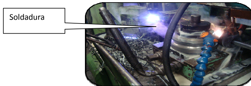
Figura 3.18: soldadura de tubería.
