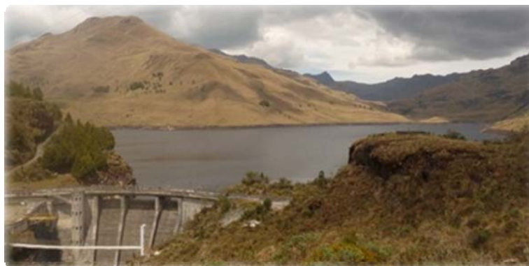
Figura 2-1: Fotografía de la Presa de Chanlud ubicada en la parte alta de la subcuenca del Río Machángara.
