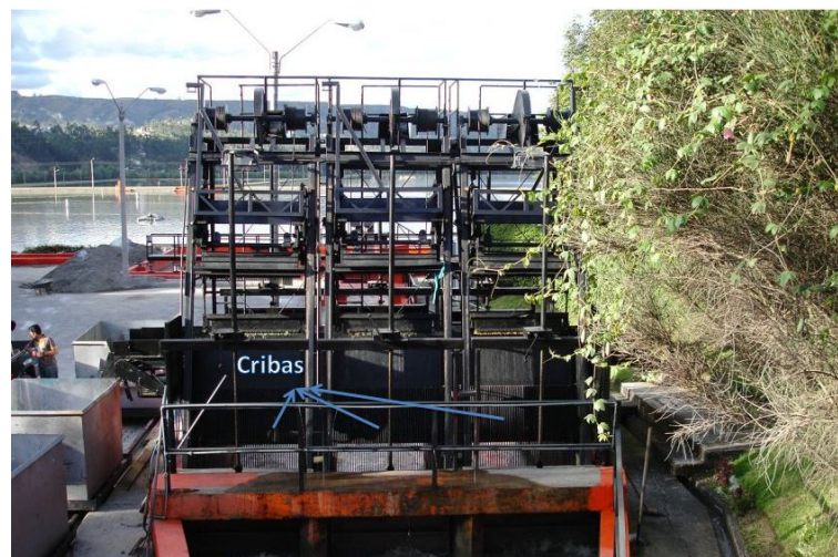
Figura 3.3: Cribas mecánicas autolimpiantes (ETAPA, 2007)
