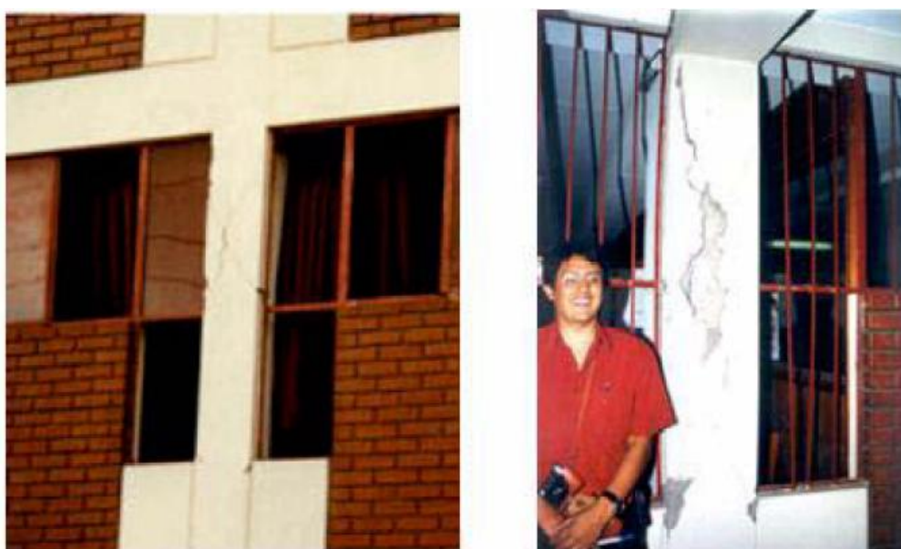
Foto 2.9. Daño típico de columna corta
