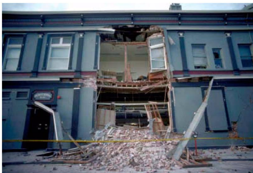
Foto 2.1. Fallo fuera del plano de dos muros de mampostería
