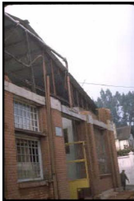
Foto 2.5. Fallo de un muro por la mala conexión entre el techo y el muro
