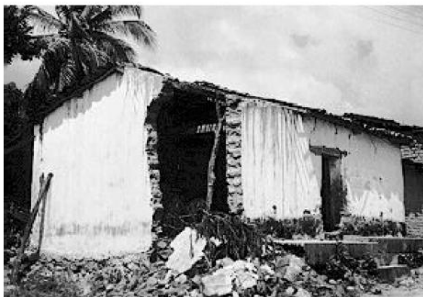
Foto 2.6. Fallo de un muro de adobe debido a conexiones inadecuadas
