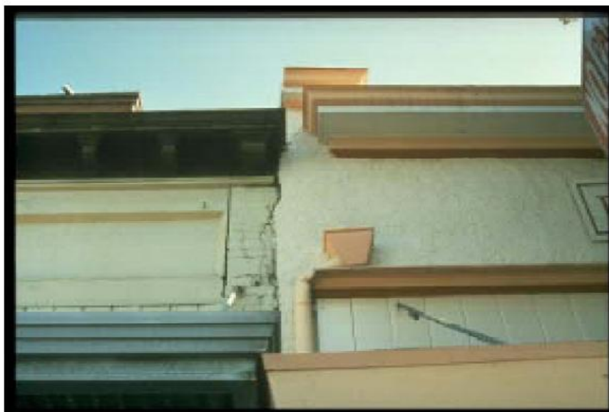
Foto 2.7. Daños producidos por el martilleo entre dos edificios vecinos
