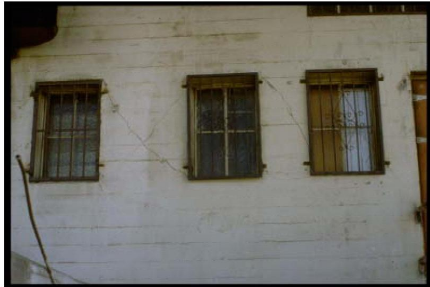
Foto 2.3. Grietas formadas por la tensión diagonal entre las ventanas de un edificio de mampostería
