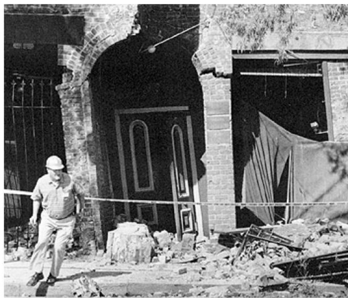
Foto 2.4. Fallo por flexión de las columnas de mampostería
