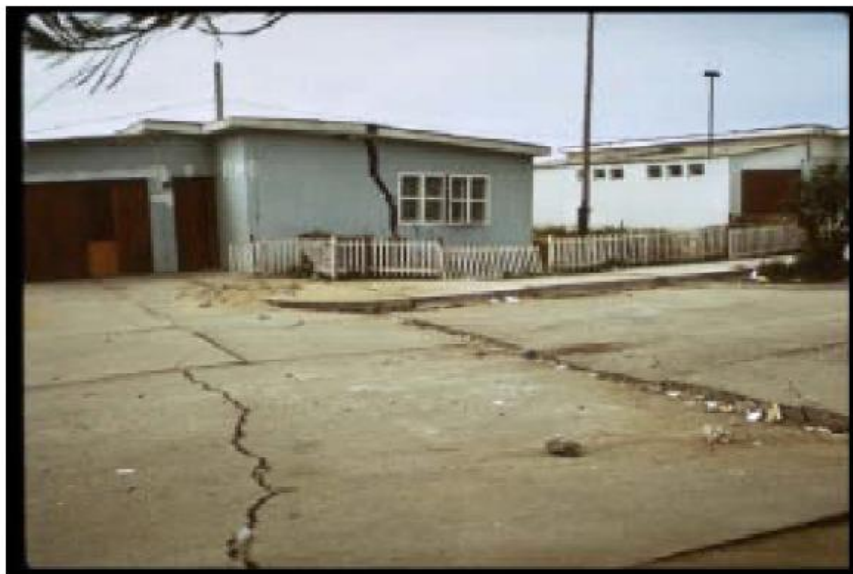
Foto 2.8. Fallo del muro de una casa por efecto de la licuefacción del suelo
