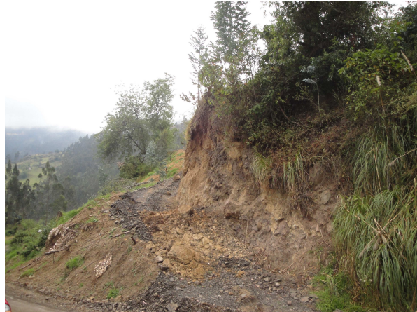
Fotografía 14. Construcción de caminos sin control
