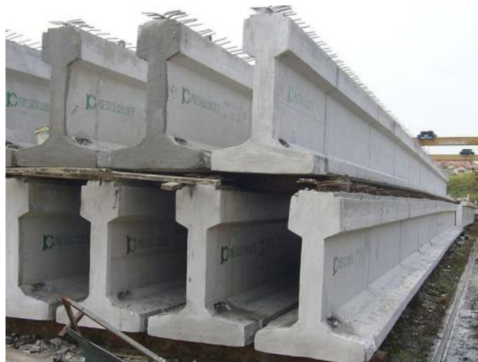
Figura 7.2.4 30 : Vigas T invertidas
