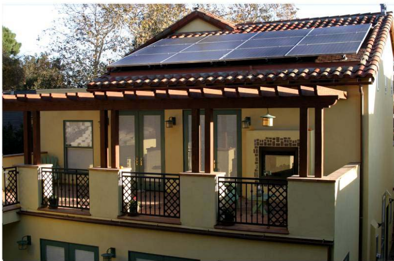
Figura 2.21 Sistemas domésticos fotovoltaicos conectados a la red.
