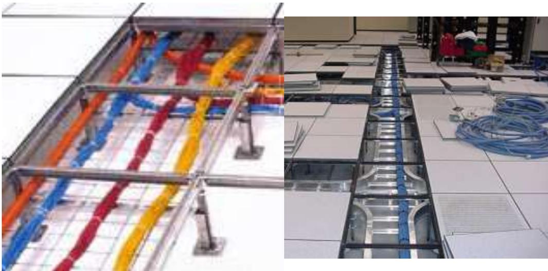
**Figura 1 - 7 Piso falso con canaletas para la distribución de cables**
