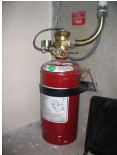
**Figura 2 - 11 Botellón de almacenamiento de gas inerte para sistema contra incendios**
