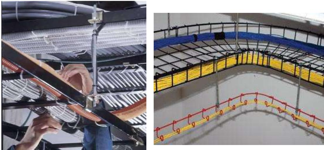
**Figura 1 - 27 Instalación de bandejas aéreas**
