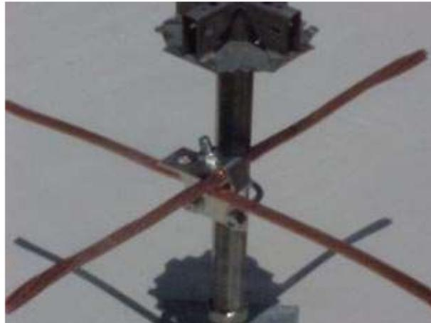
**Figura 1 - 8 Detalle de acople de la estructura del piso a la malla de puesta a tierra**
