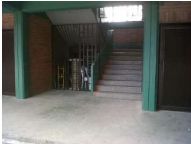
Figura 4.37: Lugar destinado a ubicarse el generador
