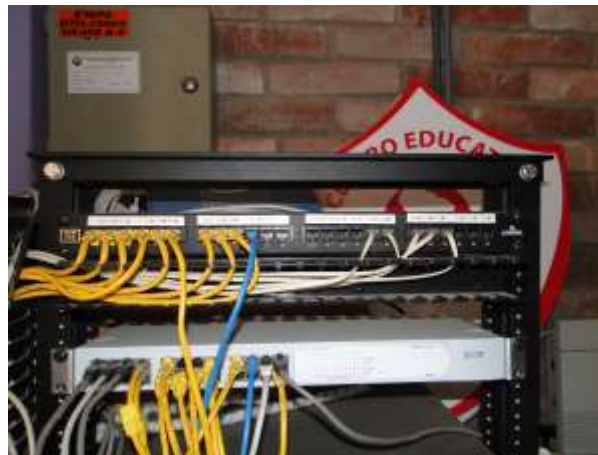
Figura 4.16: Patch Panel organizador de los cables actual
