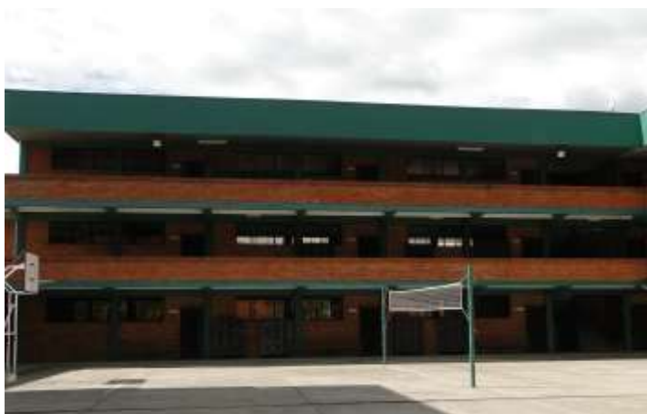
Figura 4.20: Bloque C del Colegio
