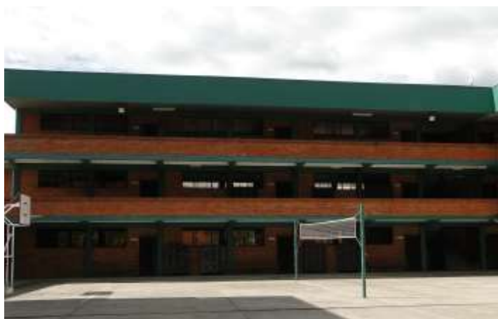
Figura 4.4: Bloque C del Colegio
