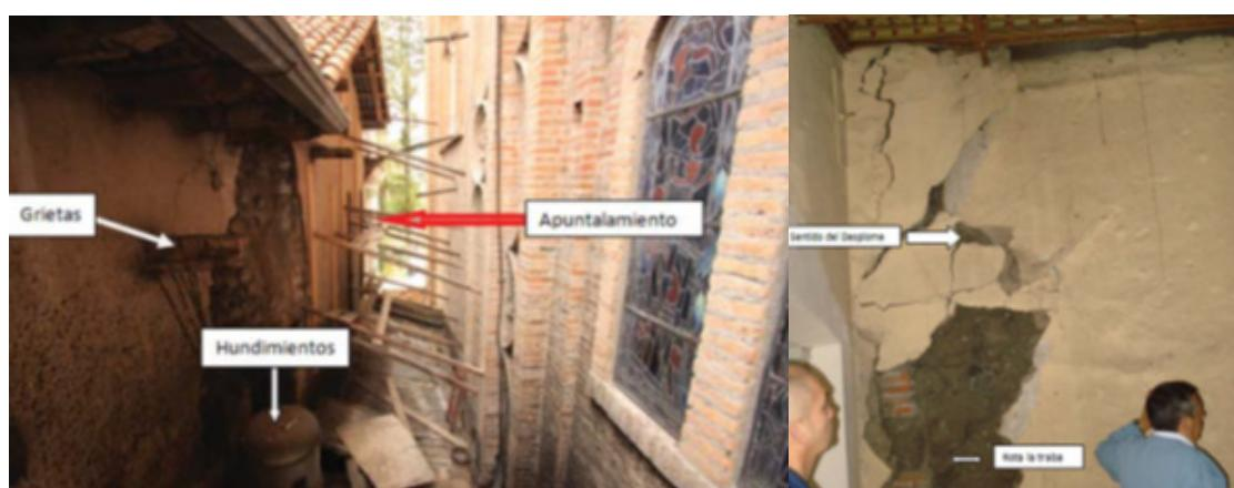
Imagen 3-61: Fotografía que ilustra el estado actual de la fachada Sur del Antiguo Seminario San Luis, 2010. Muestra la pobre apuntalamiento y la falta de muro por causa de las goteras.
