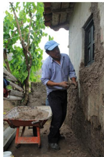
Imagen 4-21: Reparación de revoco en muro de adobe
