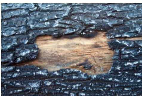
Imagen 4-23: Estructura de madera atacada por el fuego
