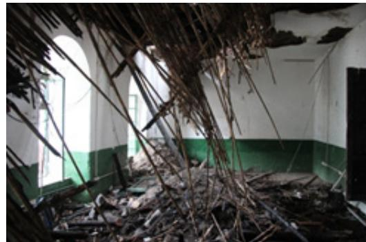
Imagen 5-10: Fotografía muestra el estado de deterioro de los cielos rasos del Antiguo Seminario Mayor, posterior al incendio.
