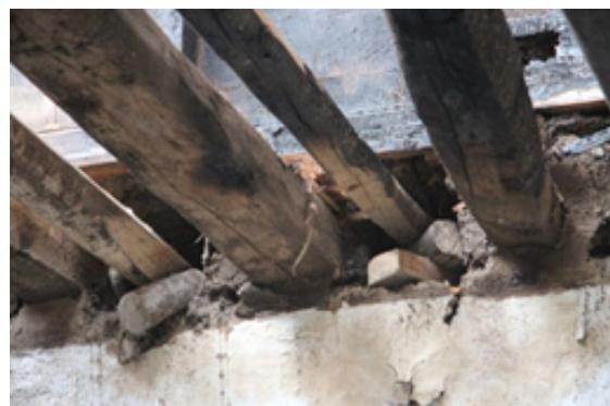
Imagen 5-4: Fotografía muestra el estado de deterioro de las cabezas de muro, posterior al incendio en el Antiguo Seminario Mayor de Cuenca.
