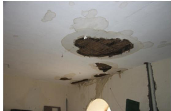
Imagen 5-21: Fotografía que muestra deterioro de uno de los cielos rasos del Antiguo Seminario Mayor por la acción del agua utilizada para aplacar el incendio.
