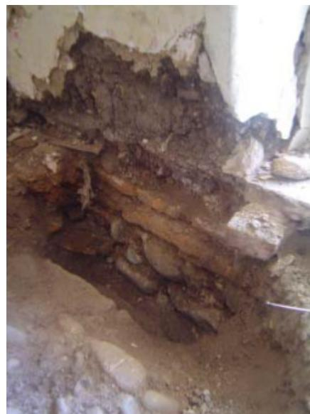
Imagen 3-37: Fotografía muestra parte de la cimentación que aparece a través de un faltante al pie de un muro. Seminario San Luis, 2010.
