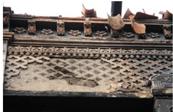
Imagen 5-18: Fotografía que muestra el estado actual de los muros de la Capilla del Antiguo Seminario Mayor, posterior al incendio.
