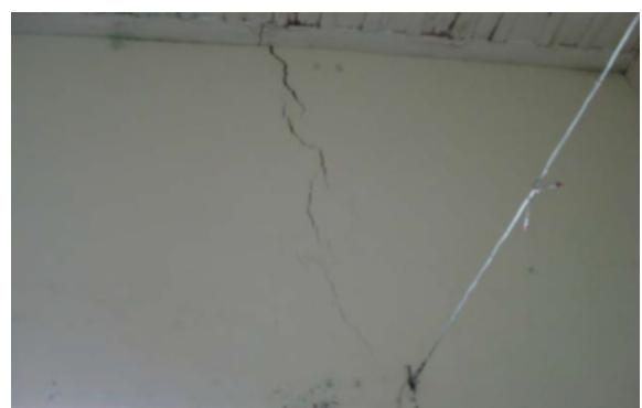
Imagen 3-64: Fotografía que ilustra el estado actual de los muros de adobe del del Antiguo Seminario San Luis, 2010. Muestra una grieta provocada por asentamiento de la cubierta.
