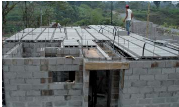
FOTOGRAFÍA 3.1.27 CONSTRUCCIÓN DE LOS MUROS PORTANTES
