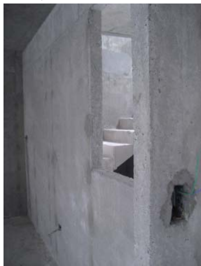
FOTOGRAFÍA 3.2.24 PAREDES INTERNAS SIN EMPASTE, SUPERFICIE RUGOSA
