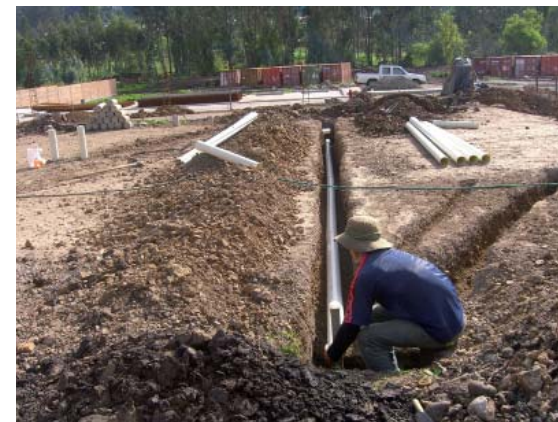
FOTOGRAFÍA 3.2.6 REDES PRINCIPALES PARA EVACUACIÓN SE AGUAS SERVIDAS BAJO LOSA DE CIMENTACIÓN.
