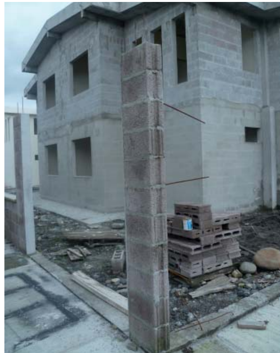
FOTOGRAFÍA 3.1.27 CONSTRUCCIÓN DE LOS MUROS PORTANTES
