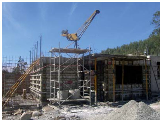
FOTOGRAFÍA 3.2.22 ESTRUCTURACIÓN DE LA PLANTA BAJA CON FORMALETAS METÁLICAS
