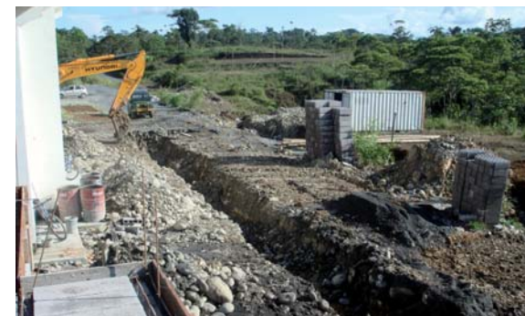
FOTOGRAFÍA 3.1.7 EXCAVACIONES PARA EL ABASTECIMIENTO DE SERVICIOS BÁSICOS
