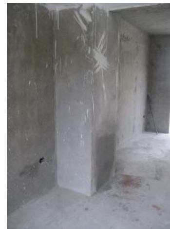
FOTOGRAFÍA 3.2.4 DUCTO PARA BAJANTE DE AGUAS SERVIDAS
