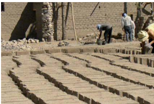
FOTOGRAFÍA 1.5.7 FABRICACIÓN DE BLOQUES DE ADOBE
