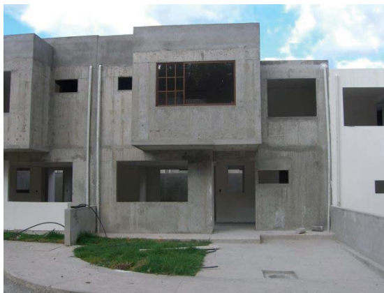
FOTOGRAFÍA 3.2.3 BAJANTES DE AGUAS LLUVIAS VISIBLES
