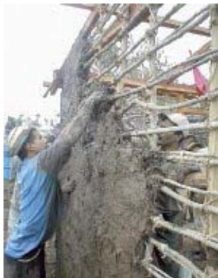
FOTOGRAFÍA 1.5.6 CONSTRUCCIÓN DE UNA PARED DE BAHAREQUE
