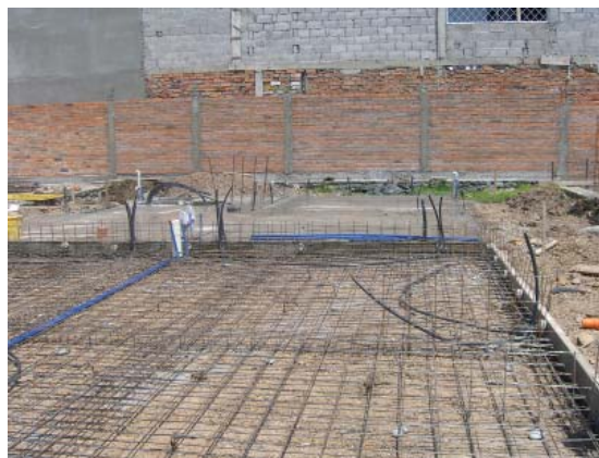
FOTOGRAFÍA 3.2.5 INSTALACIONES DE TUBERÍAS DE AGUA POTABLE EN LOSA DE CIMENTACIÓN.
