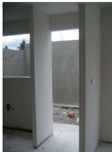
FOTOGRAFÍA 3.2.25 PAREDES INTERNAS RECUBIERTAS CON EMPASTE
