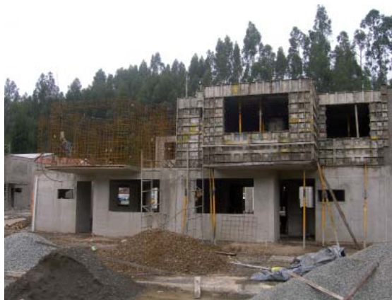
FOTOGRAFÍA 3.2.23 ESTRUCTURACIÓN DE LA PLANTA ALTA CON FORMALETAS METÁLICAS
