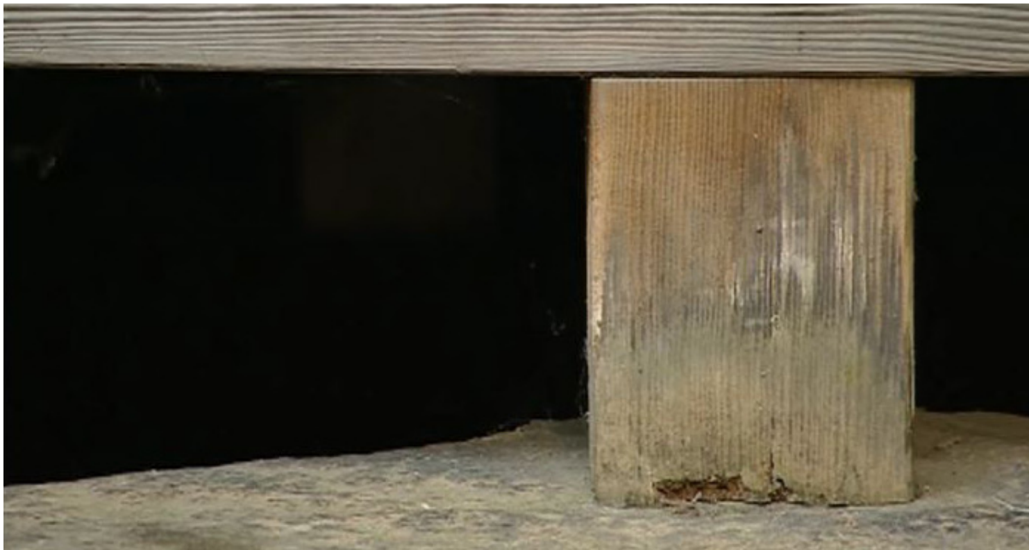
37. El sistema estructural se basa en estructuras de madera apoyadas directamente en el piso, sin ningún tipo de anclaje.
