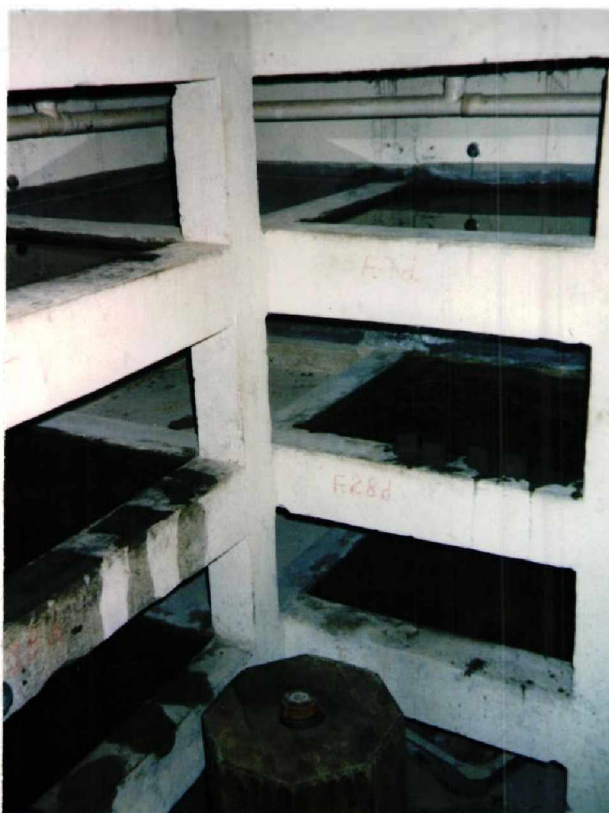
TANQUES DE ALMACENAMIENTO PARA EL CURADO DE LOS BLOQUES.
