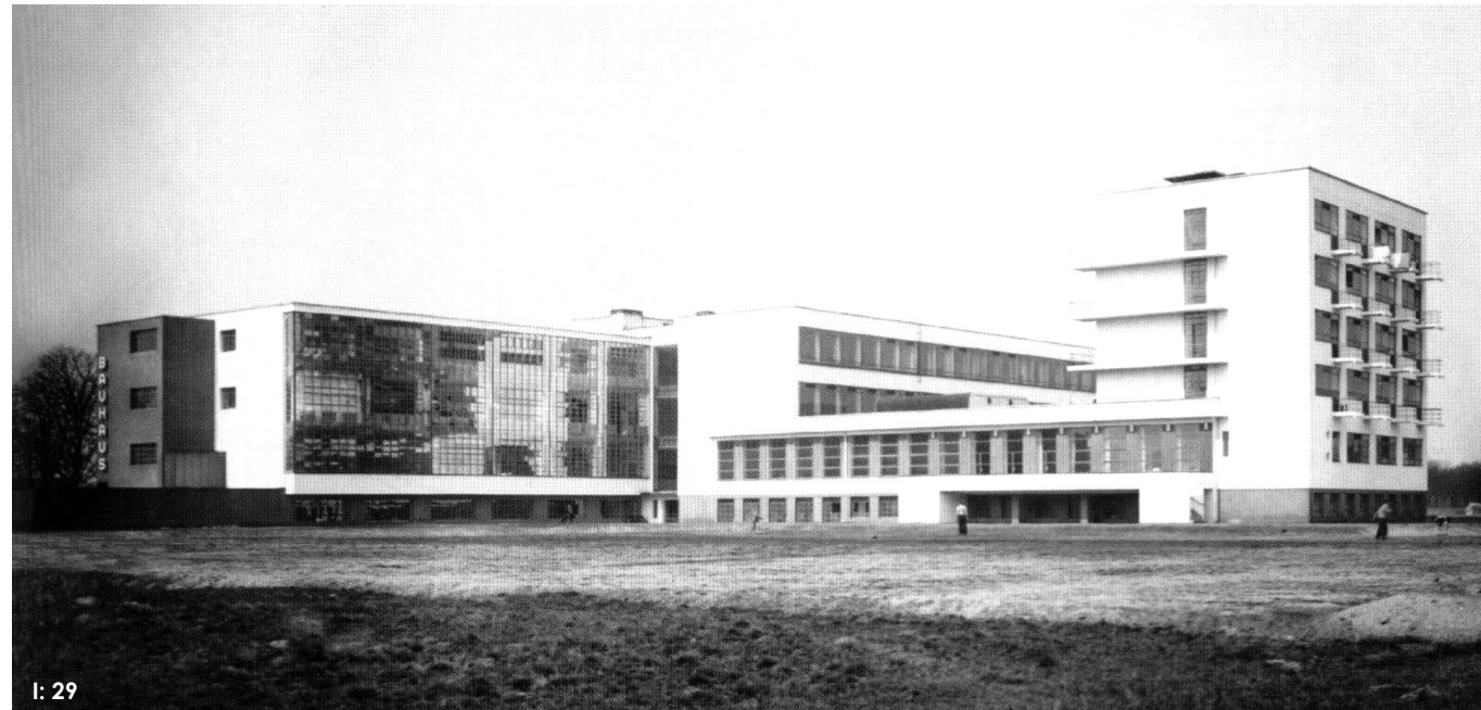
I 29: Walter Gropius, Edificio de la Bauhaus en Dessau, 1925. Droste Magdalena, Bauhaus, 2006. Pág 47.
