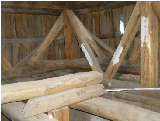
nivel 1, estructura, reticulados fotografía: La Autora
