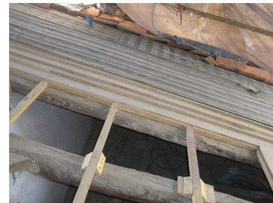
sobre las correas, madera trípex y sobre ésta, latillas, Iglesia de Todos Santos fotografía: la Autora
