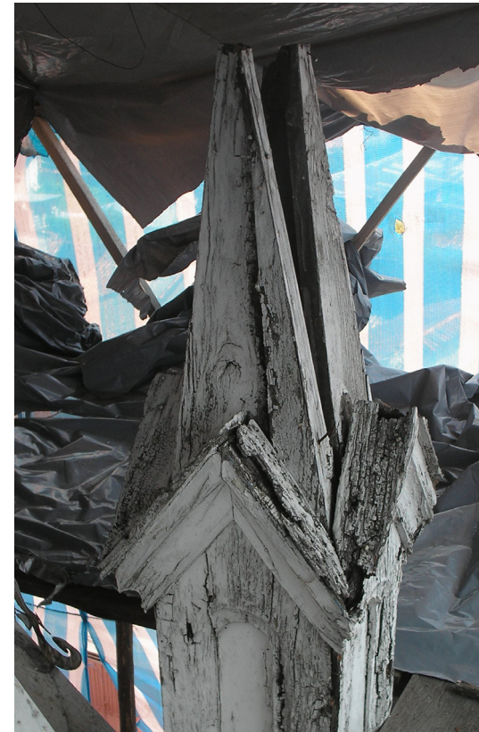
acción del agua en la madera, Iglesia de Todos Santos
