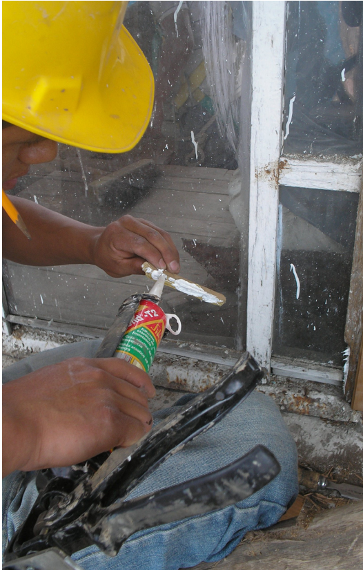
colocación de chirlatas, en la parte inferior de la ventana fotografía: la Autora
