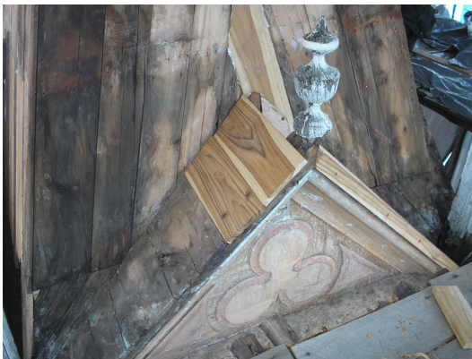
sustitución de elementos dañados, por piezas de teca fotografía: la Autora
