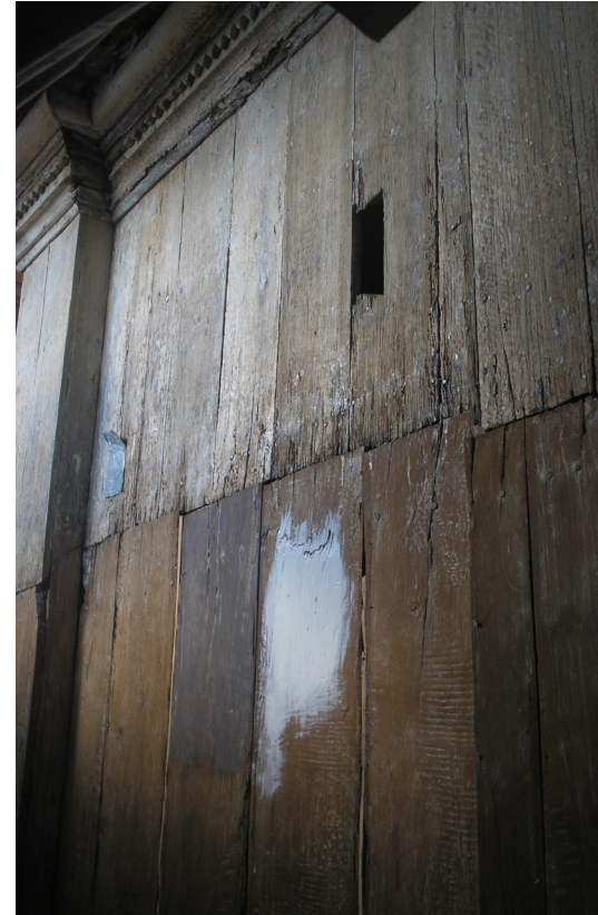
implementación de nuevos elementos en partes dañadas de la madera fotografía: la Autora
