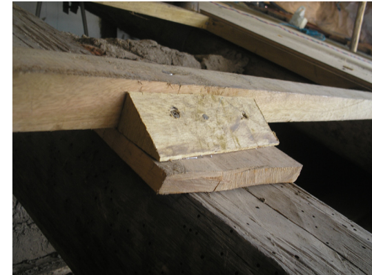
soporte de la correa; sobre el par, se encuentra un taco de madera utilizado para alcanzar el nivel requerido para las correas, Iglesia de Todos Santos fotografía: la Autora
