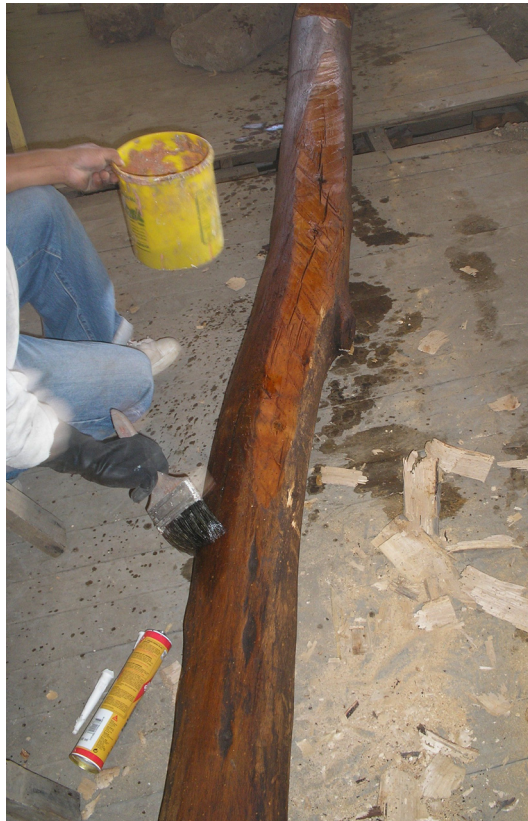
métodos de tratamiento sin presión, por brocha. Iglesia de Todos Santos
