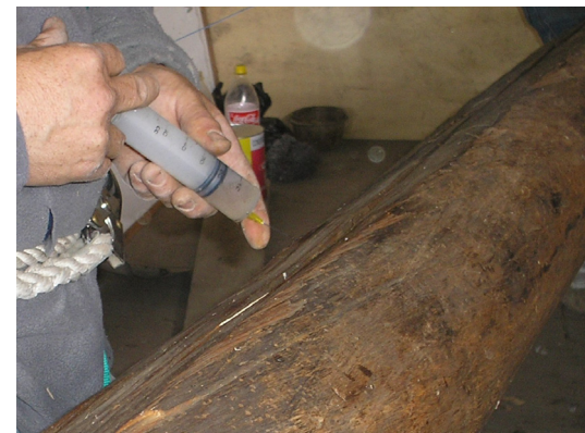
inyecciones de químicos, como el merulex, para evitar la presencia de agentes xilófagos, Iglesia de Todos Santos fotografía: la Autora
