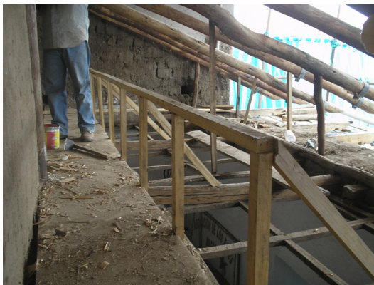
caminería sobre la nave lateral norte, Iglesia de Todos Santos fotografía: la Autora
