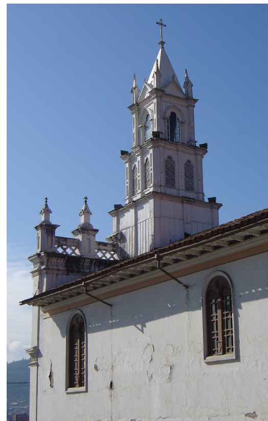
Restauración de la Torre de la Iglesia de Todos Santos Archivo Fotográfico: José Delgado
