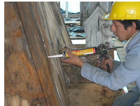
colocación de chirlatas, gracias a la ayuda de químicos como el Sika Bond T2 fotografía: la Autora
