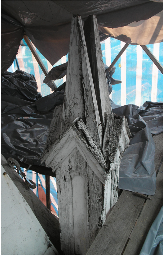
estado de los pináculos, antes de la restauración fotografía: la Autora
