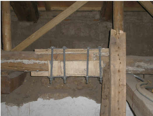
cumbrero reforzado con piezas de madera nueva y con platinas de hierro, Iglesia de Todos Santos fotografía: la Autora
