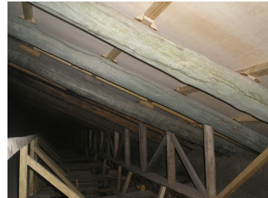
sustitución de pares, debido al pésimo estado que se encontraban los originales, Iglesia de Todos Santos fotografía: la Autora
