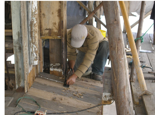
sustitución de elementos, debido al mal estado de los originales fotografía: la Autora
