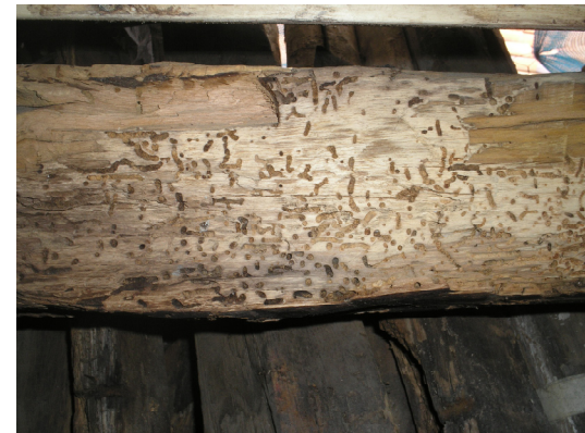
acción de insectos de ciclo larvario en piezas de madera Iglesia de Todos Santos
