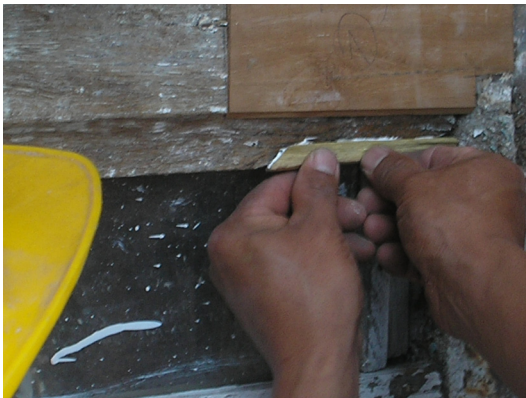
ampliación de la pieza de madera colocada en la parte inferior de la ventana fotografía: la Autora
