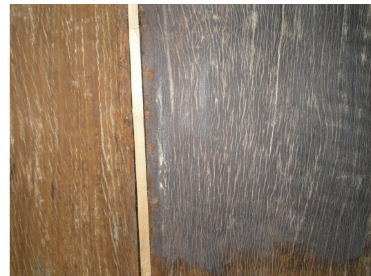
colocación de piezas de madera en uniones de tablas fotografía: la Autora
