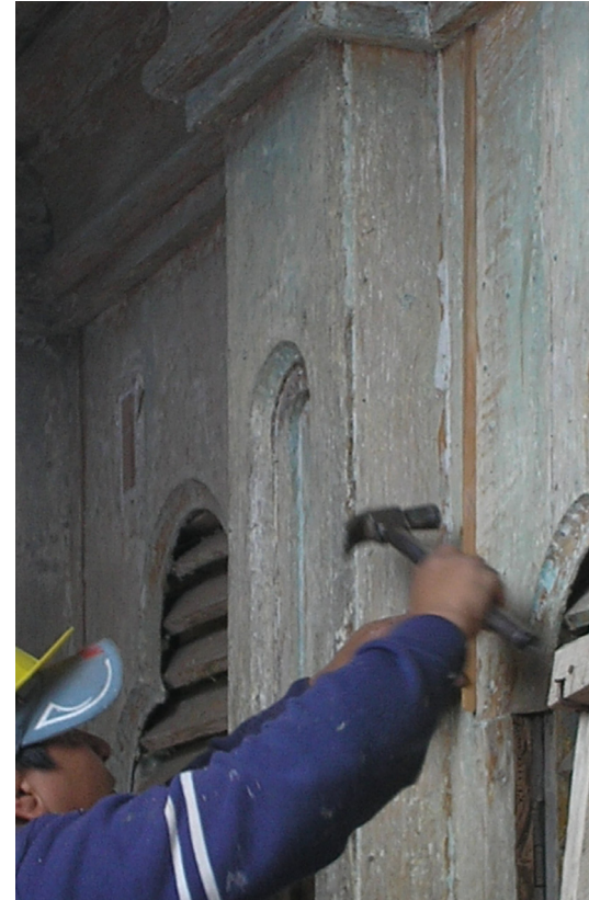
cololación de chirlatas, en zonas donde se ha visto daños de la madera fotografía: la Autora
