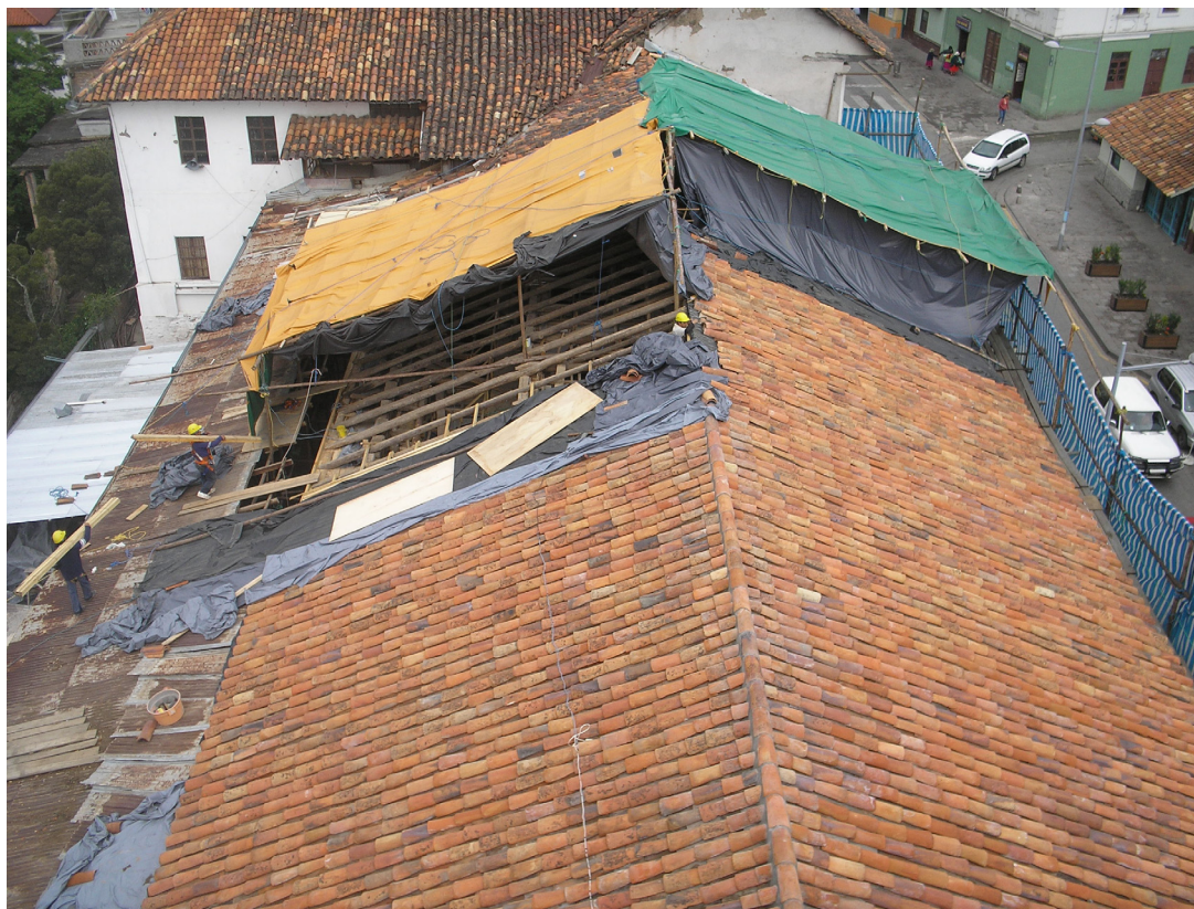
Restauración de la cubierta de Todos Santos, 2009 fotografía: la Autora
