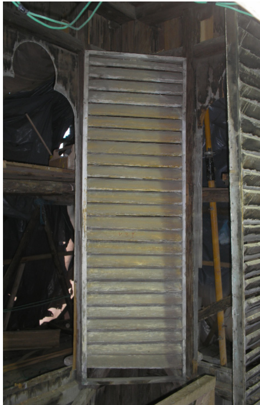
nivel 2, ventana de madera. laminas fotografía: La Autora
