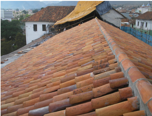
cubierta de la nave de la Iglesia de Todos Santos, ala sur
