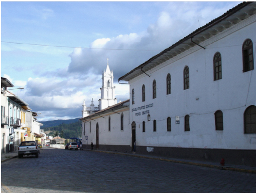
Iglesia de Todos Santos, fachada norte Archivo fotográfico Arq. Felipe Quesada
