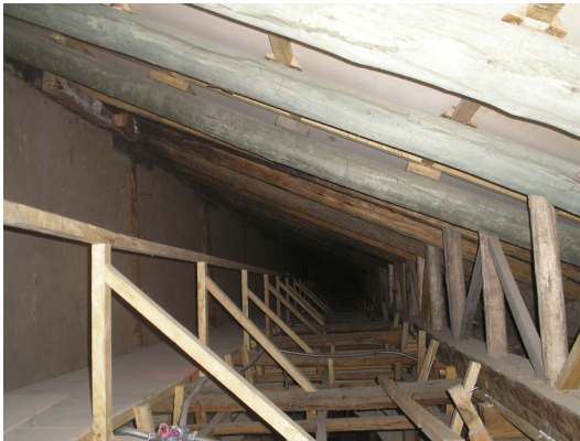
caminería correspondiente a la nave lateral sur, Iglesia de Todos Santos fotografía: la Autora
