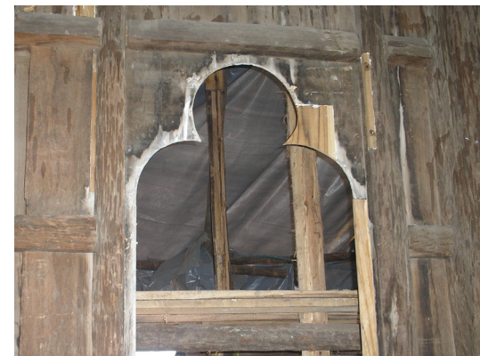
colocación de piezas de madera afectadas, por la humedad fotografía: la Autora
