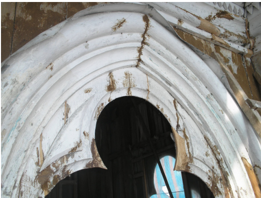
nivel 3, latón colocado sobre los arcos para evitar daños fotografía: La Autora
