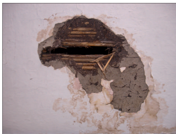
DAÑO EN CIELO RASO Ambiente: 4 FUENTE: Grupo de Tesis
