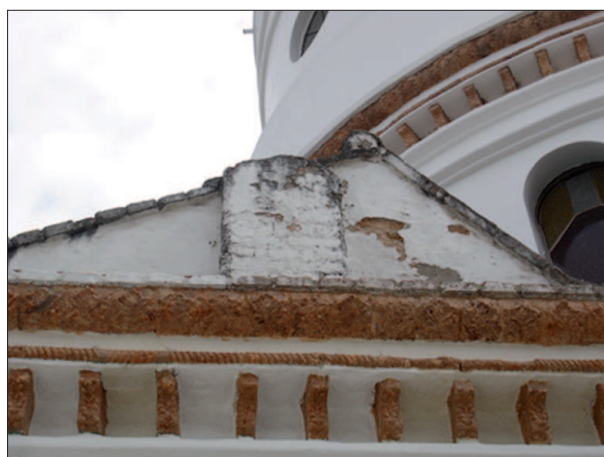
ILUSTRACION 7: Erosión por viento en muro de la Iglesia FUENTE: Grupo de tesis.
