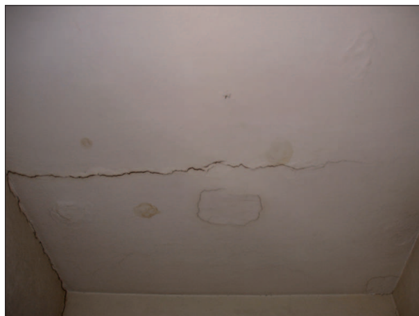
DAÑO EN CIELO RASO Ambiente: 1 FUENTE: Grupo de Tesis
