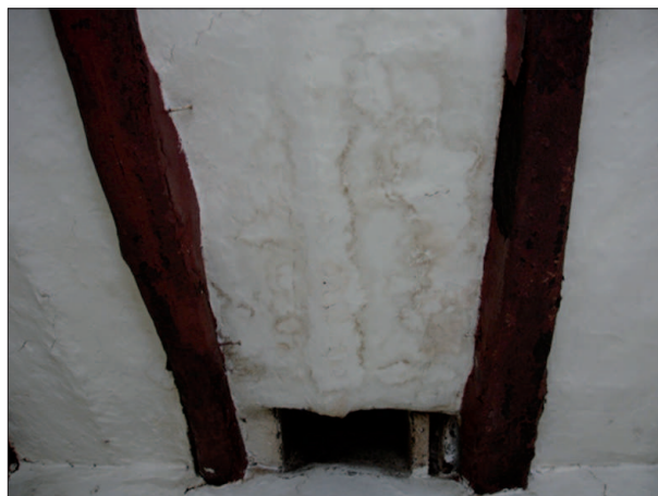
DAÑO EN CIELO RASO Ambiente: 2 FUENTE: Grupo de Tesis
