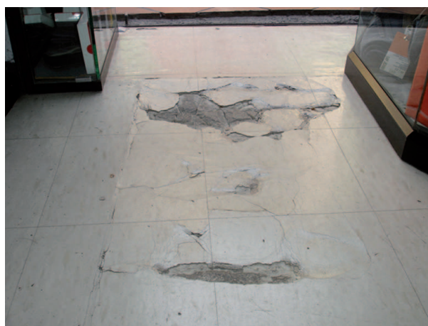
DAÑO EN PISO Ambiente: 9 FUENTE: Grupo de Tesis
