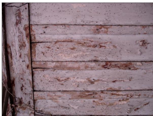
DAÑO EN CIELO RASO Ambiente: 1 FUENTE: Grupo de Tesis
