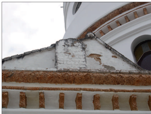
DAÑO EN MURO Ambiente: 3 FUENTE: Grupo de Tesis
