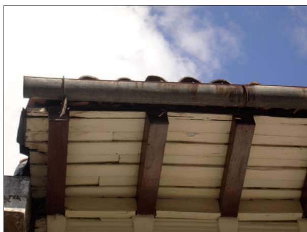
DAÑO EN CANAL Ambiente: Cubierta FUENTE: Grupo de Tesis
