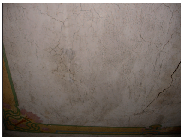
DAÑO EN CIELO RASO Ambiente: 3 FUENTE: Grupo de Tesis
