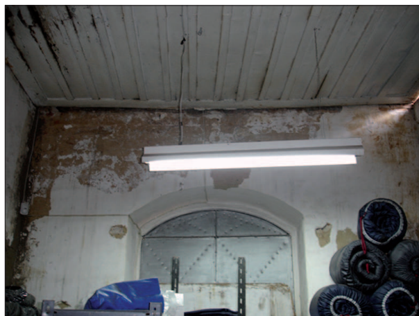
DAÑO EN CIELO RASO Ambiente: 7 FUENTE: Grupo de Tesis
