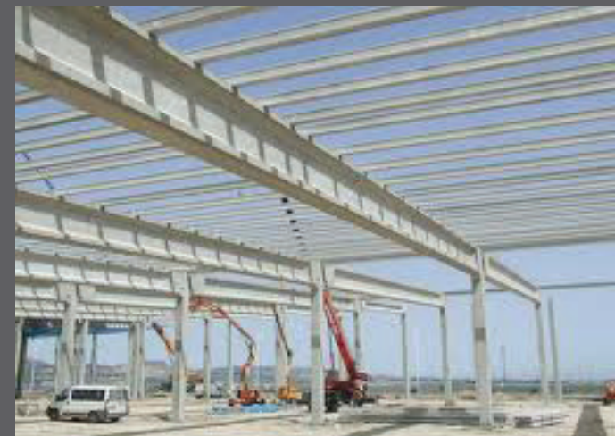
Imagen 80: Estructura de hormigón pretensado
