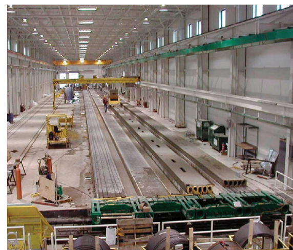
Imagen 77: Fábrica de concreto en Obra
