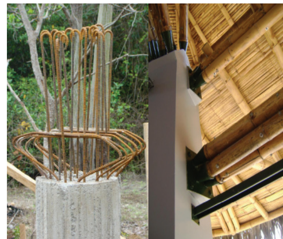
Imagen 105: Unión columna - bambú
