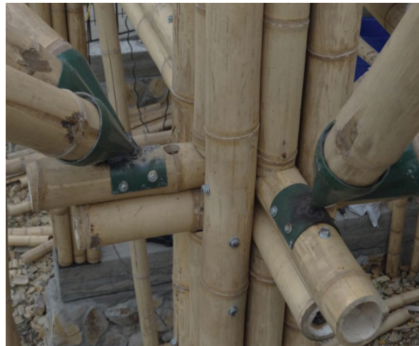
Imagen 109: Unión de bambúes con anclaje metálico
