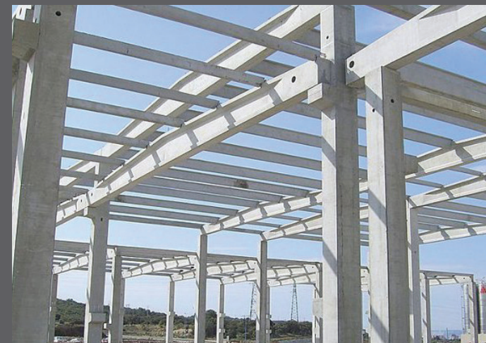
Imagen 79: Estructura de hormigón pretensado
