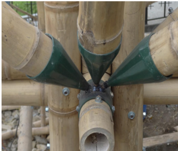
Imagen 107: Unión de bambúes con anclaje metálico
