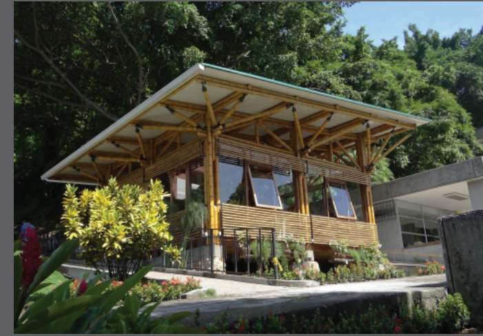
Imagen 110: Construcción de bambú
