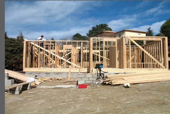
Imagen 23: Construcción en madera
