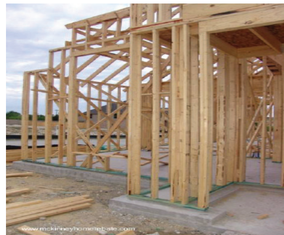
Imagen 25: Estructura de Madera
