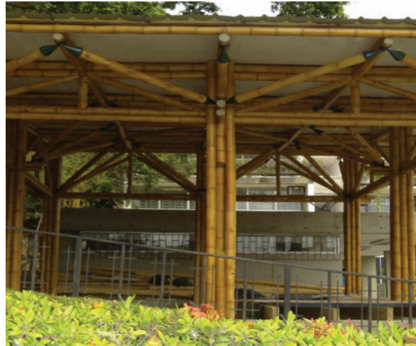
Imagen 108: Construcción de bambú
