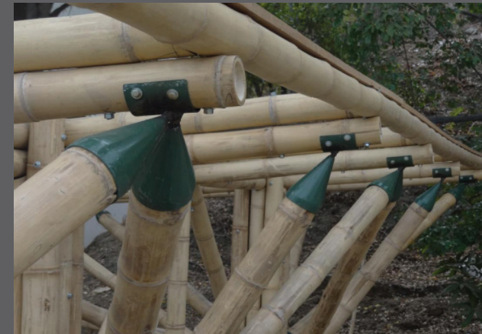
Imagen 111: Unión de bambúes con anclaje metálico
