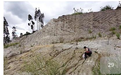
29. Taludes inestables y de gran altura existentes en el A.E. Fuente: Propia.
