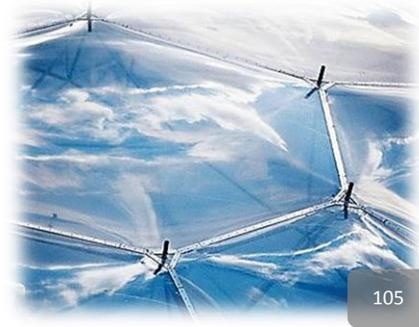
105. Detalle de la fijación de los paneles EFTE para la construcción de las cúpulas geodesias en el proyecto Edén.
