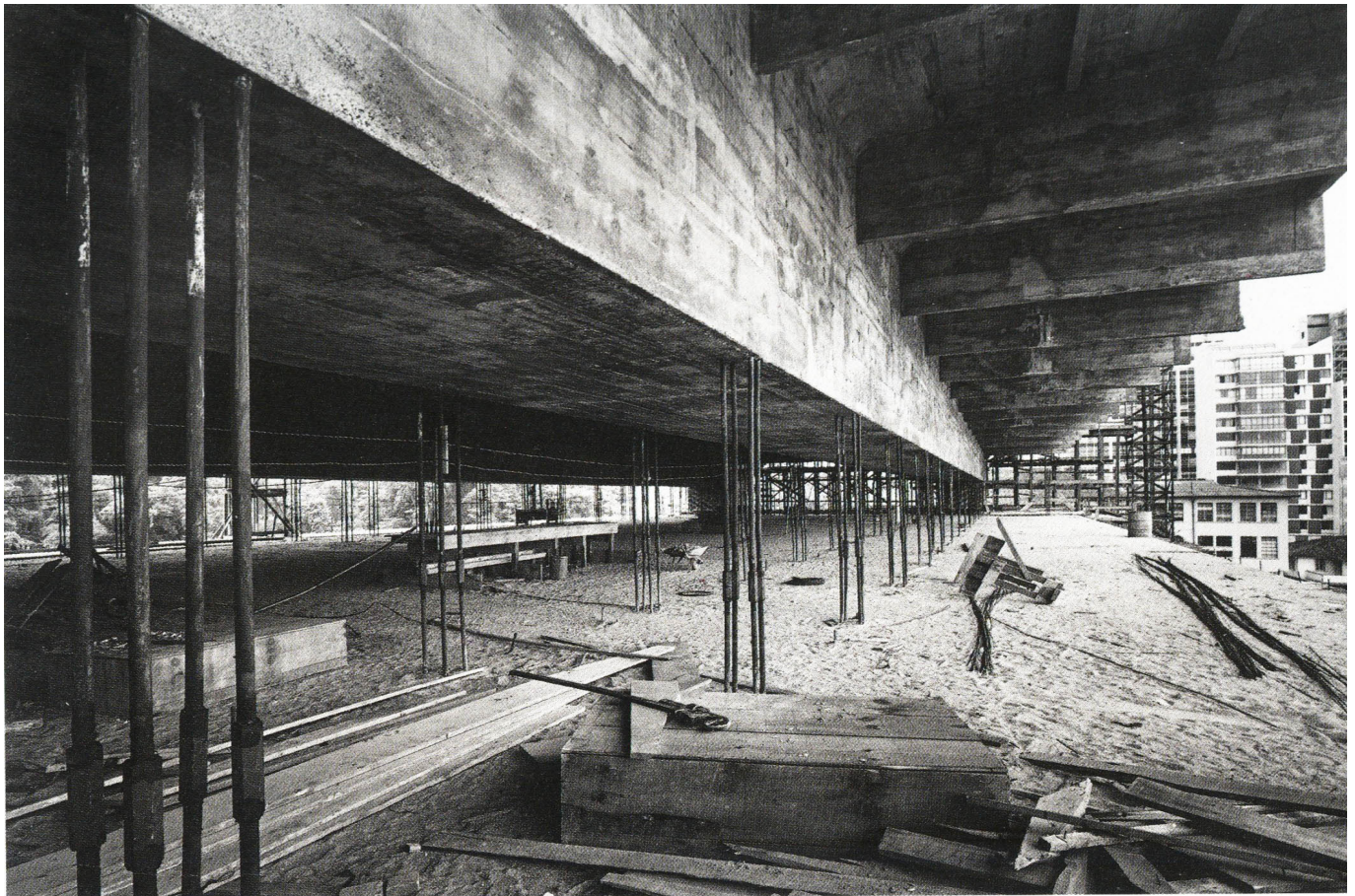
78. Construcción de MASP - detalle de tensores internos nivel =8.40
