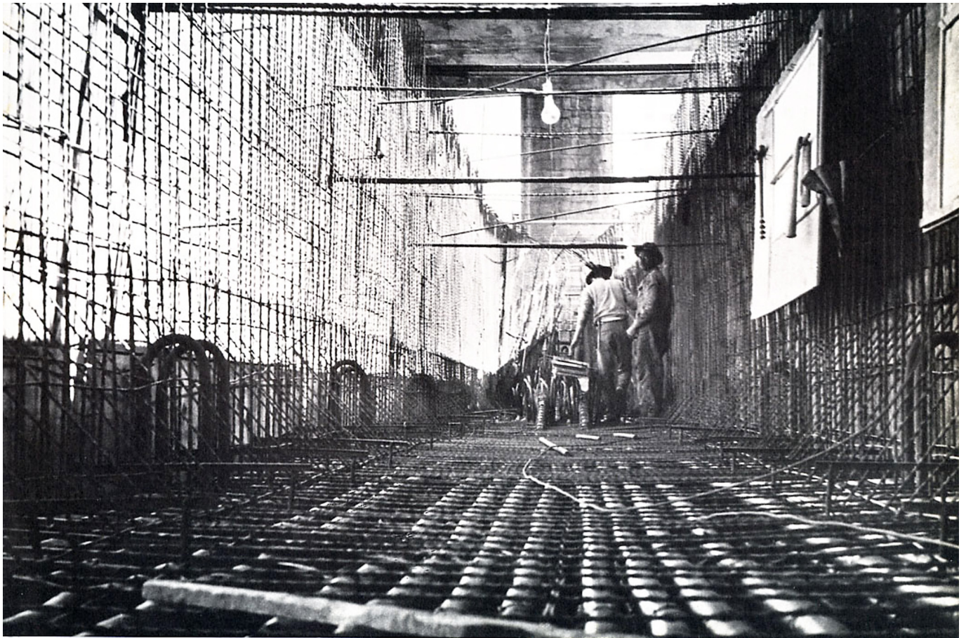
79. Construcción de MASP - detalle armado de vigas
