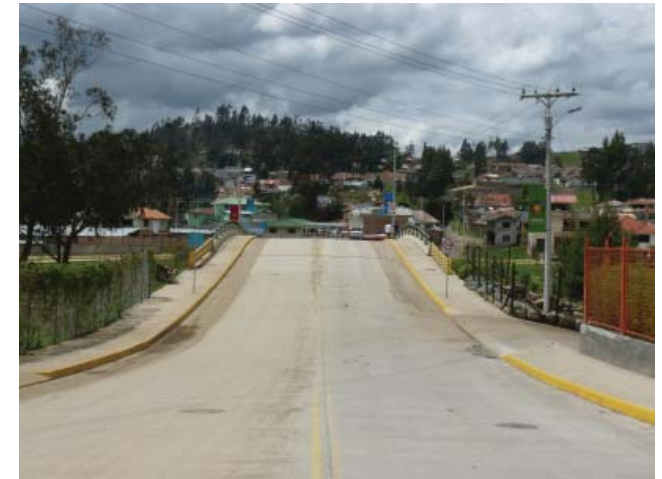
acceso puente de misicata
