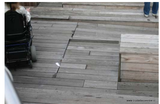
16. Detalle de tope de seguridad para ubicar un coche o silla de ruedas
