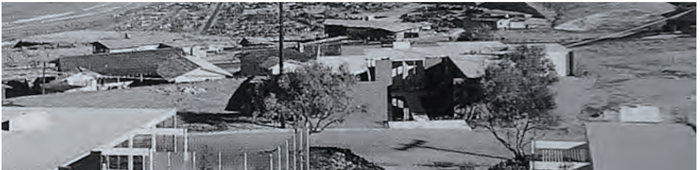
11. CSH #23 b, prismas de chimenea sobresalen de las cubiertas.
