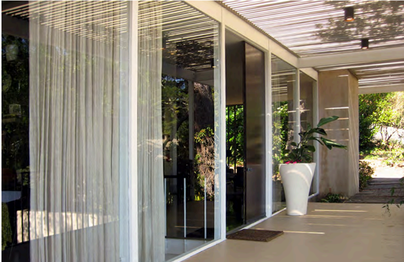
31. Casa Spaulding, el volumen de la chimenea sobresale en la terraza y atraviesa la pérgola.
