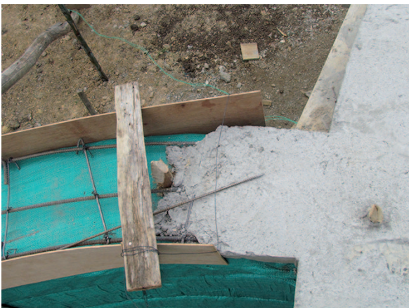
85. Armado y fundido del encofrado de las circunferencias laterales
