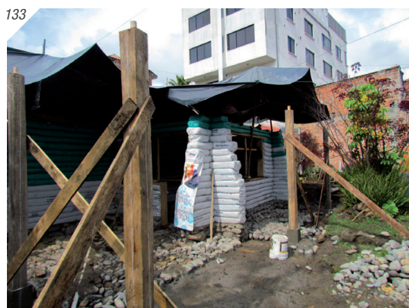
133. Colocación columnas-Método caja y espiga
