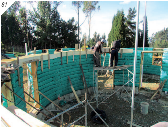
81. Cadena de hormigón armado sobre Superadobe 82. Preparación del encofrado
