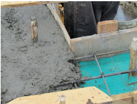
83. Fundición de la cadena de Hormigon Armado
