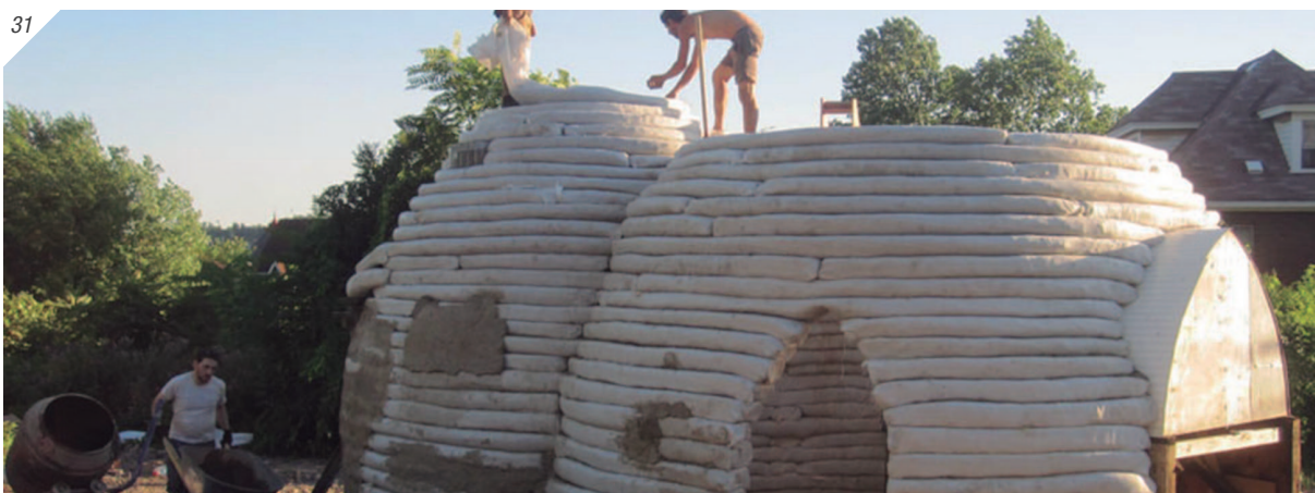
31. Domos levantados con bolsas de polipropileno.
