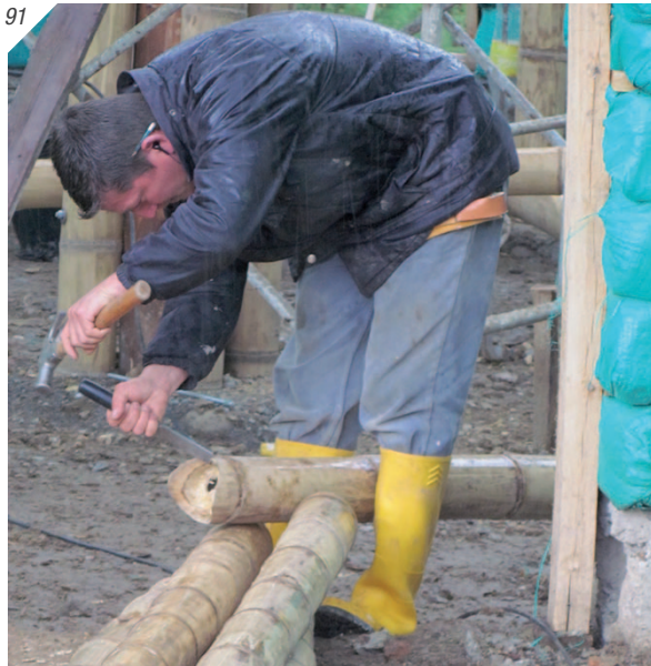
91. Uniones de los elementos de caña, acoplados 92. Inyectado de Hormigón en las cañas guaduas.
