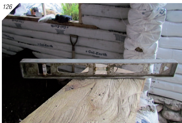
124. Jamba para la puerta con marco de eucalipto 125. Sobrepaso del tablón del alfeizar 126. Nivelación del tablón del alfeizar
