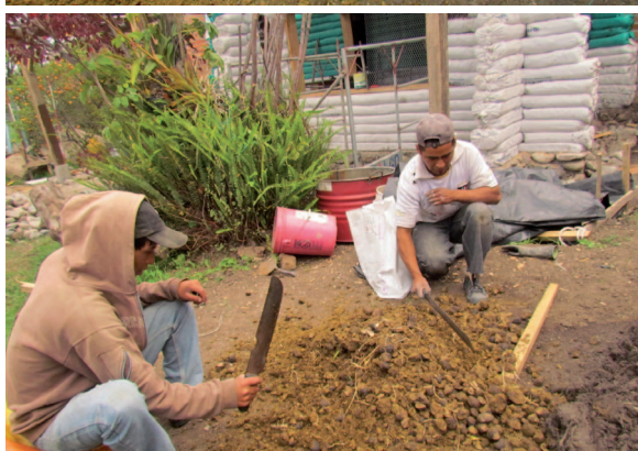
160. Preparación tierra de revoque
