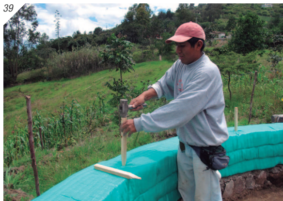
38. Los alambres de púas unen las bolsas y aseguran los techos 39. Estacas de madera clavadas en los sacos
