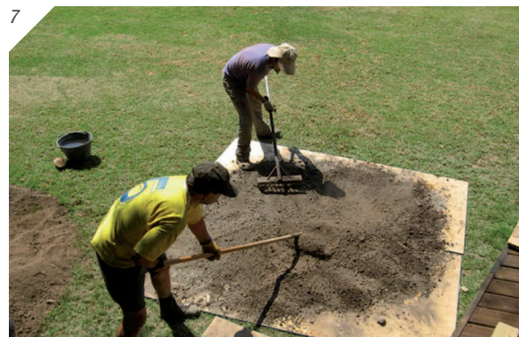
7. Mezcla de tierra con estabilizante (cemento)
