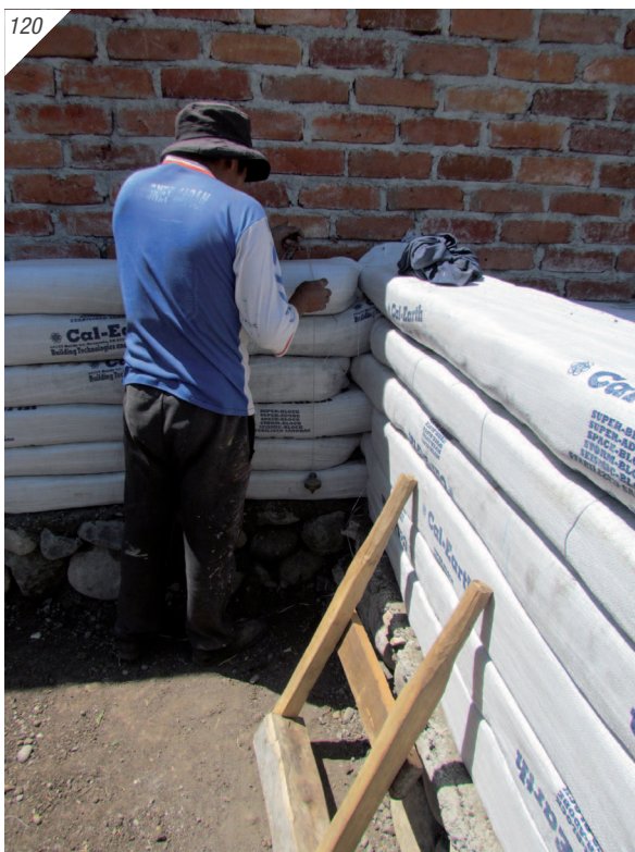
119. Compactación con el pisón 120. Comprobación de la verticalidad 121. Estacas de doble punta
