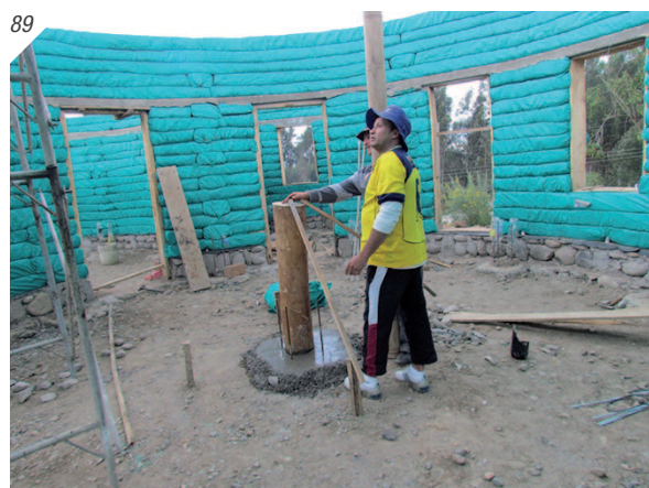
88. Replanteo de piedra para la columna central 89. Cadena moldeada con un tronco de madera 90. Cañas guaduas que se insertaron en las varillas
