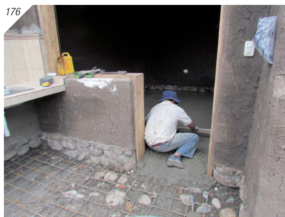
174. Replanteo de piedra 175. Preparación del Hormigón 176. Malla de Acero R-106
