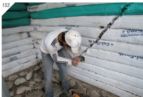
153. Canal para instalación
