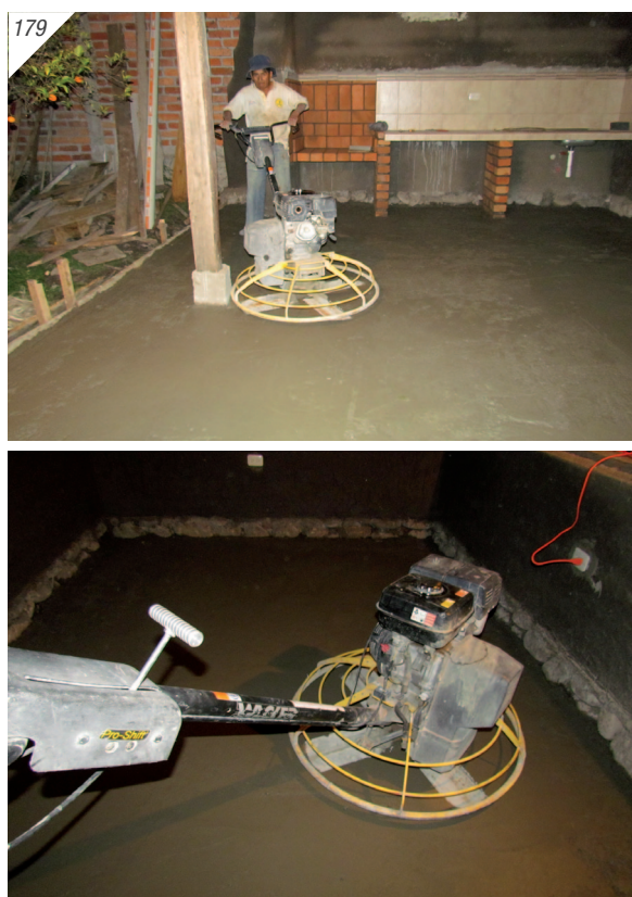
179. Pulido de la chapa de concreción
