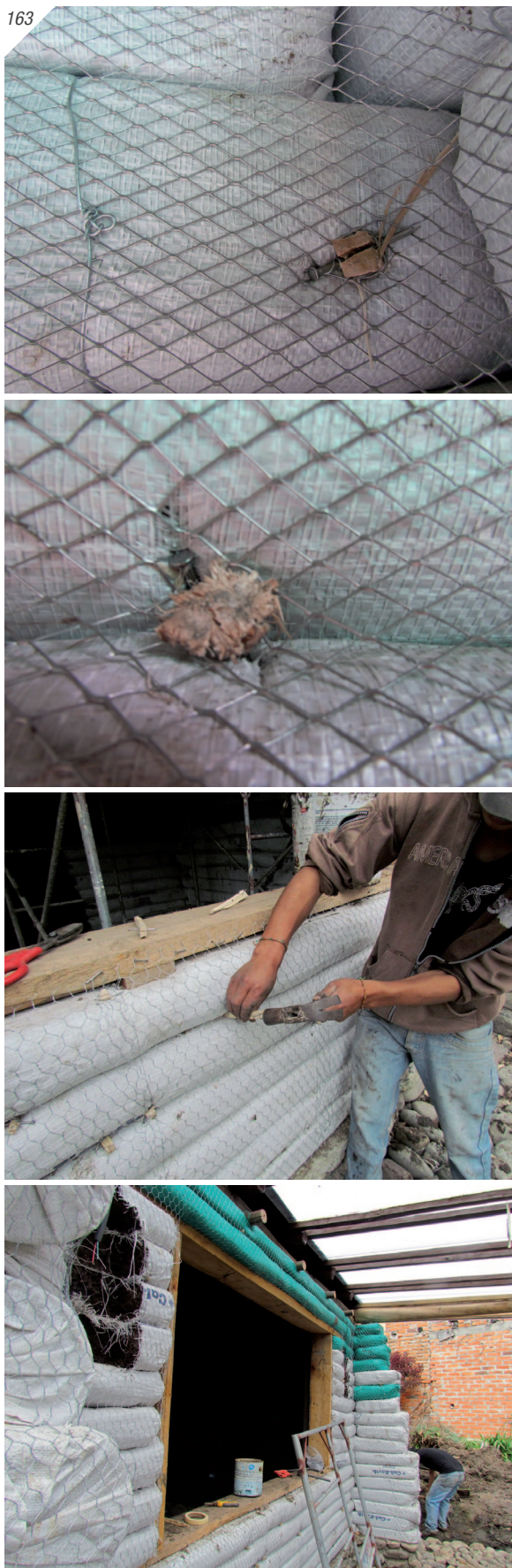
163. Colocación de las diferentes mallas
