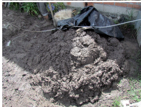
162. Secuencia de la mixtura añadiendo fibras naturales (cabuya de sisal)
