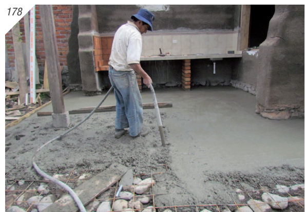
177. Colocación de maestras 178. Vibrado del Hormigón.
