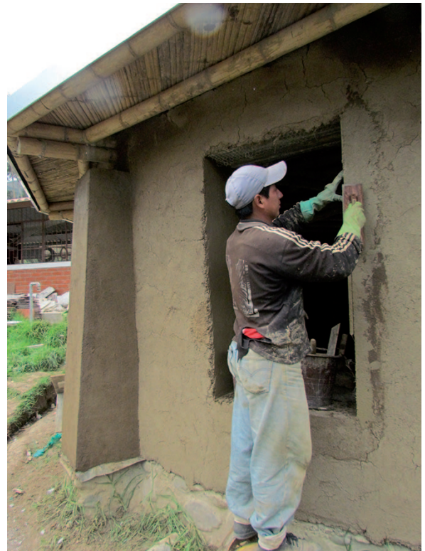
102. Preparación de dinteles y cadena de hormigón para el revoque
