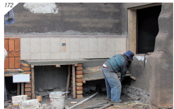
171. Vertido del Hormigón en la Loseta 172. Desencofrado de la Loseta
