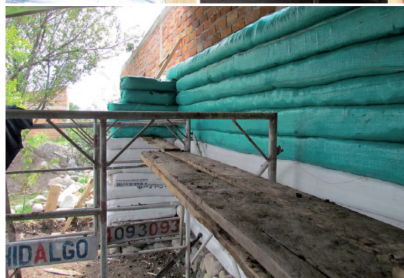
127. Dintel de ventana 128. Andamios provisionales para ubicación de hiladas superiores
