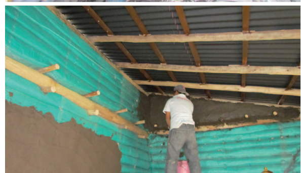
164. Diferentes pruebas de revoque
