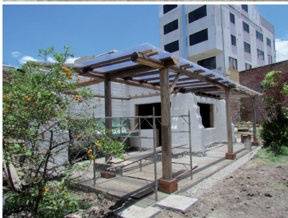
182. Encalado de construcción de Superadobe
