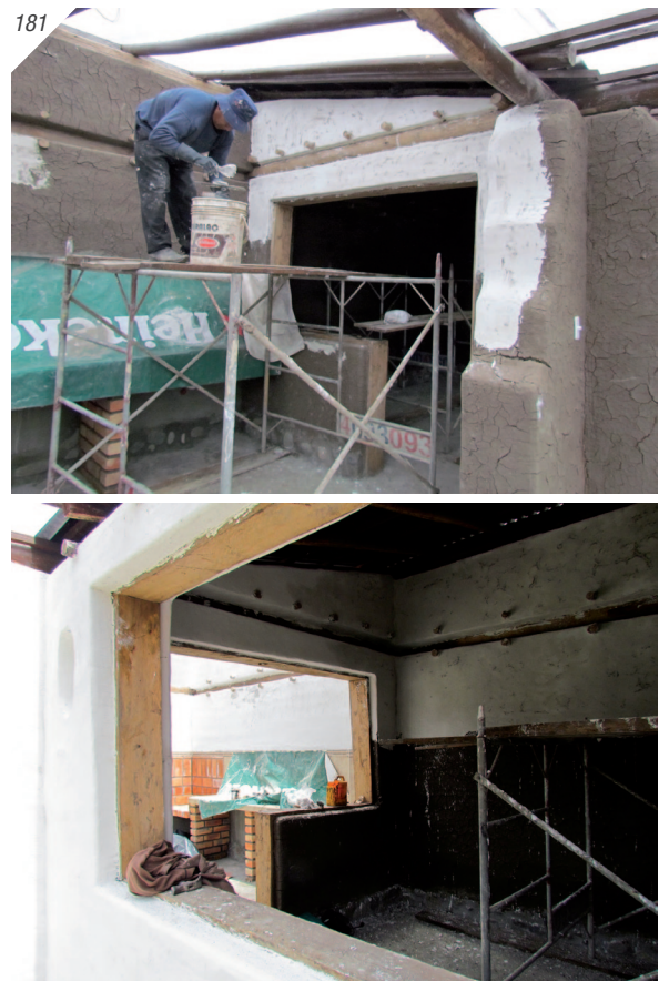
181. Proceso de encalado paredes exteriores
