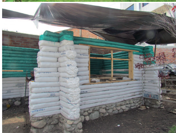
131. Nivel de instalación de vigas
