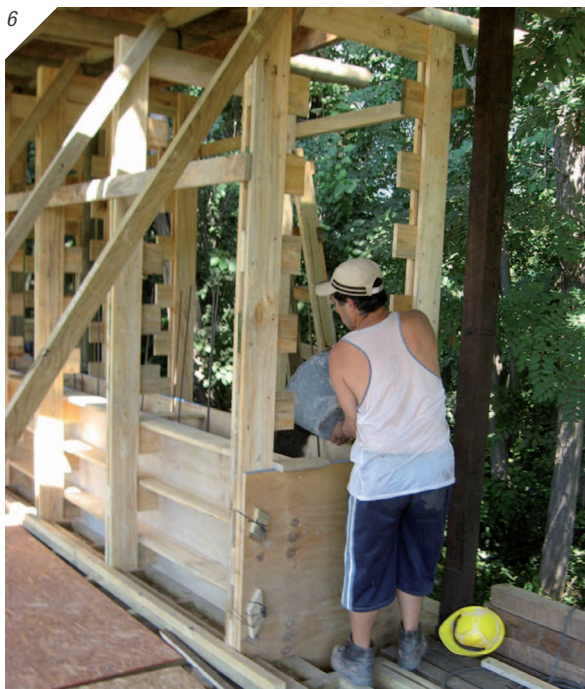
6. Relleno de encofrado con capas de tierra húmeda
