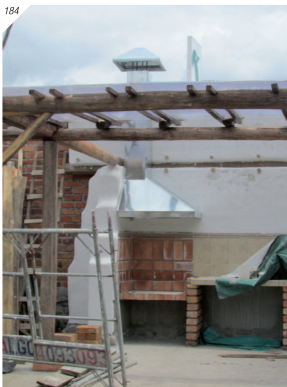
183. Anclaje de la campana de humo 184. Campana de humo
