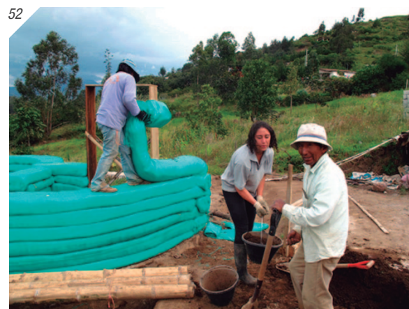
52. Embutido y colocado de las bobina, apoyándolas en la pierna
