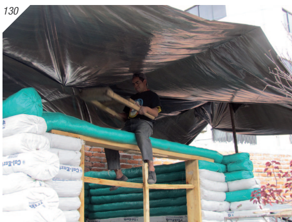
129. Llenado del material de sandbag, hilada superior 130. Compactado de las bolsas
