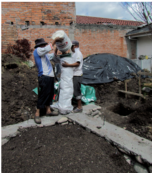
116. Técnica del llenado de Sacos 117. Primera Hlada de Superadobe 118. Baldes como embudo y pala
