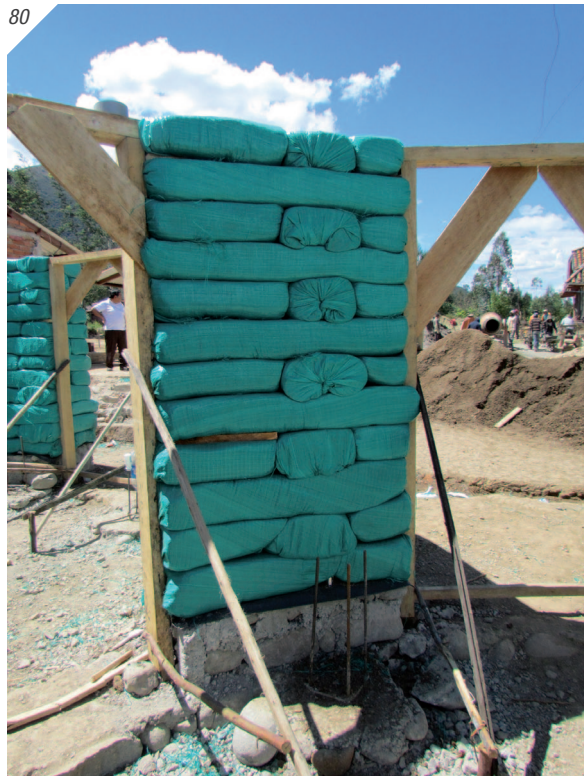
80. Preparación de marcos para distintos vanos
