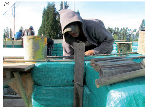
81. Cadena de hormigón armado sobre Superadobe 82. Preparación del encofrado
