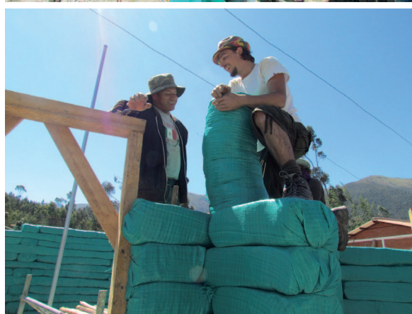
76. Llenado de los sacos continuos 77. Pisón y paleta para compactación del material
