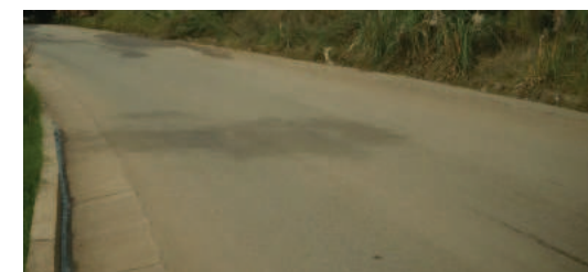
Camino de Asfalto.
