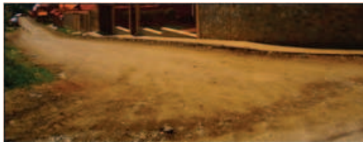
Estado Regular de la vía
