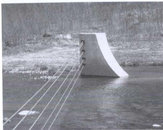
Figura 12. Contrafuerte central de un dique a cable.
