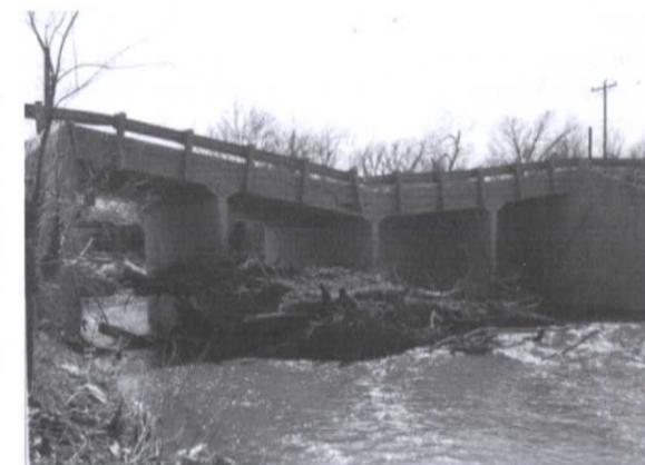
Fig. 4. Los troncos acumulados aguas arriba de un puente han causado su rotura (Fuente: [6]).
