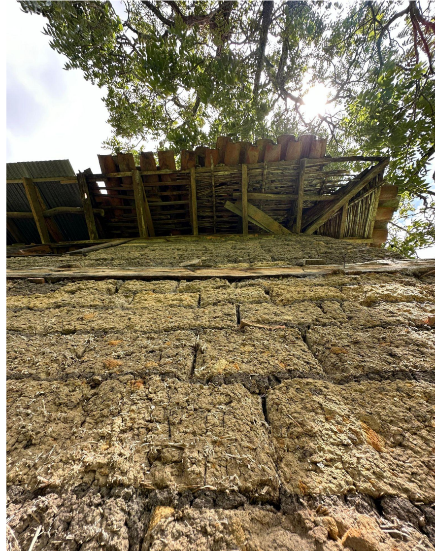
Fotografía 4. Muro de adobe, casa del barrio San Isidro.
