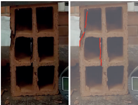
Figura 2.15. Falla por separación de paredes internas en unidades de ladrillo 2B.
