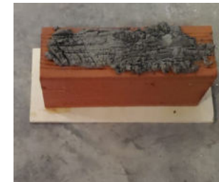
Figura 2.43. Colocación de mortero.
