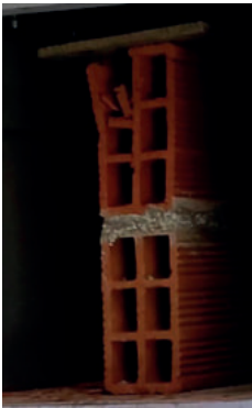
Figura 2.57. Falla por separación de caras en murete 5.
