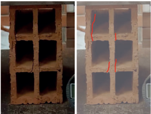
Figura 2.33. Falla por separación de paredes internas de ladrillo 5B.
