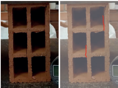
Figura 2.30. Falla por separación de paredes internas en unidades de ladrillo 5A.
