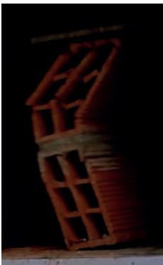
Figura 2.48. Falla por flexión en murete 2.
