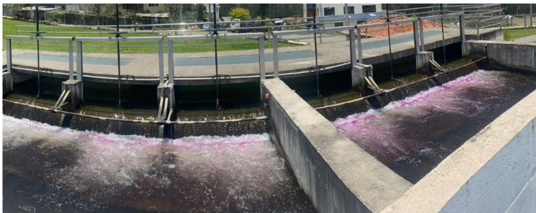
Figura 3. Dosificación de la solución de permanganato de potasio para el agua cruda.
