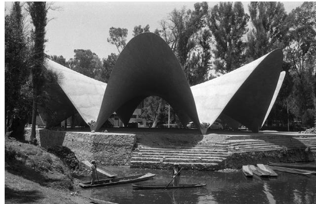
Nota: Desarrollado por el arquitecto constructor mexicano Félix Candela, donde se experimenta con estructuras de concreto armado tipo cascarón. Fuente: web (2023).
