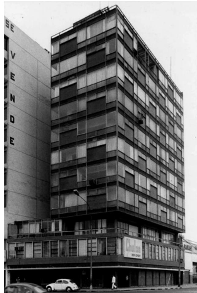
Nota: Se precisa como volumetría un paralelepípedo adosado que contiene el paquete de ascensores y escaleras, el otro volumen, principal, tiene de manifiesto el cantiléver. Fuente: web (2023).
