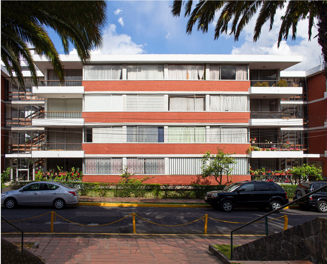
Fig.112: Fachada edificio tipo E Elaboración propia
