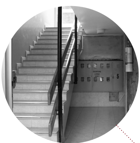
Fig.170: Escalera Elaboración propia
