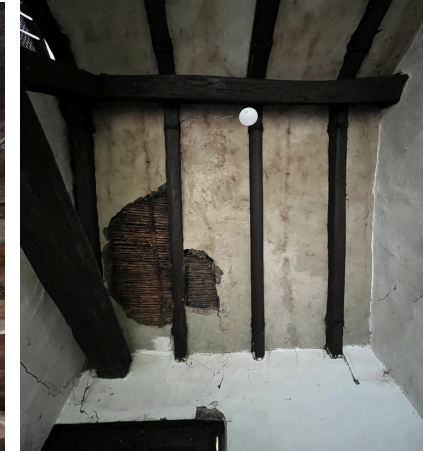
Figura 5.35. / Estructura entrepiso vista. Figura 5.36 / Enchaclado y barro.
