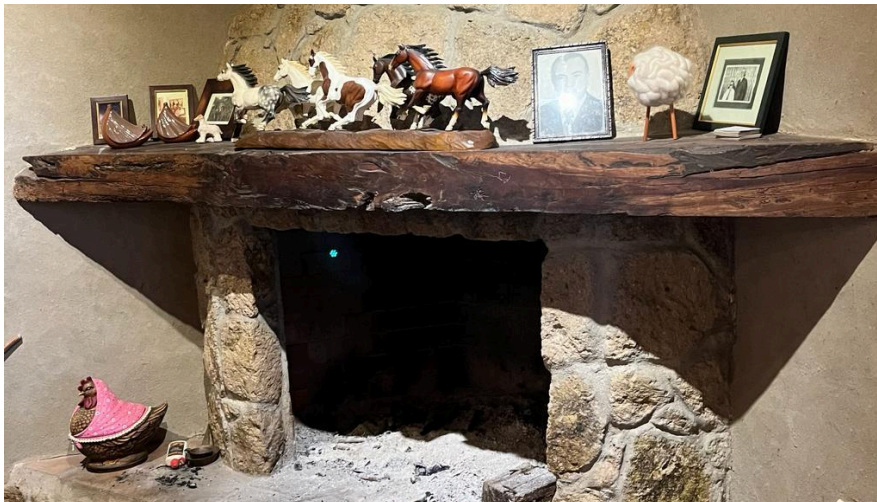
Figura 4.37 / Chimenea de la casa principal / Antiguo dintel de capulí reutilizado en la chimenea central. / Fuente: Juan Ignacio Serrano Suárez.
