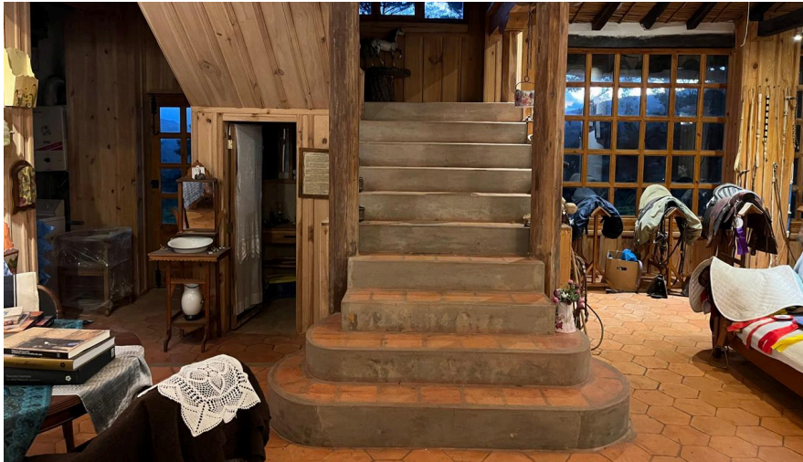
Figura 4.8 / Nueva granada de hormigón construida en el interior de la casa principal. / Fuente: Juan Pablo Serrano Neira.
