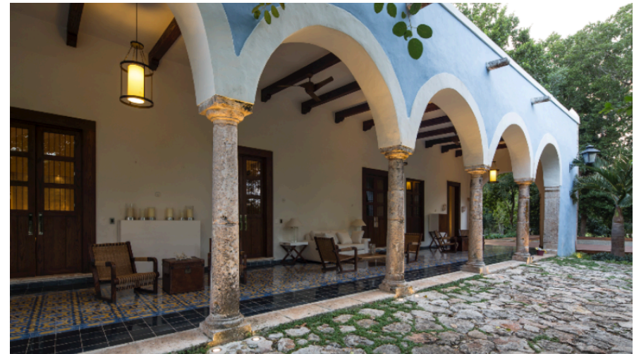
Figuras 2.6, 2.7, 2.8 y 2.9 / Hacienda San Antonio Chablé, posterior a la restauración. / Fuente: Eduardo Calvo Santisbón.
