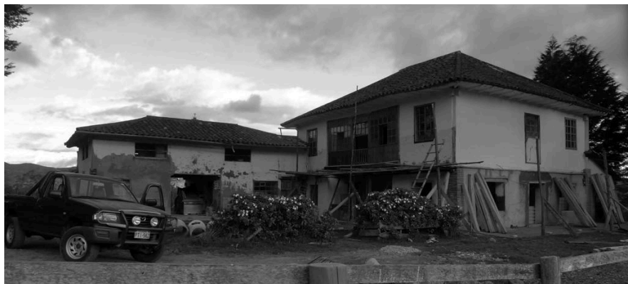
Figura 4.6 / Hacienda Gullanzhapa antes de la reparación. / Fuente: Juan Pablo Serrano Neira.
