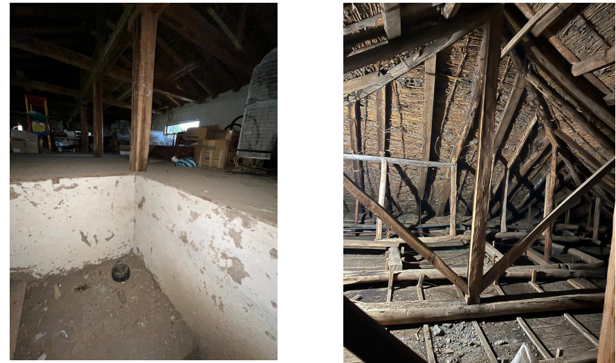
Figura 4.38 y 4.39 / Estructura y enchaclado cubierta en los bloques de la Hacienda Gullanzhapa, espacios más amplios / Vigas, columnas y puntales de eucalipto. / Fuente: Juan Ignacio Serrano Suárez.
