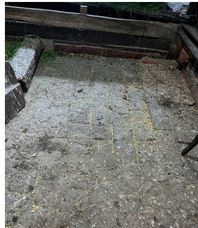
Figura 5.42 / Ladrillo antiguo cocina.
