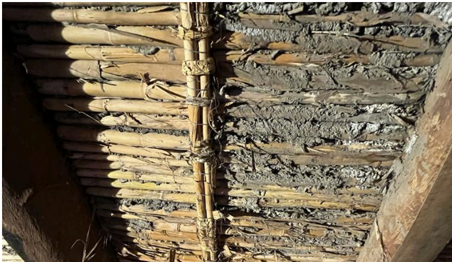
Figura 4.40 / Enchaclado en la casa principal / Cubierta casa principal. / Fuente: Juan Ignacio Serrano Suárez.
