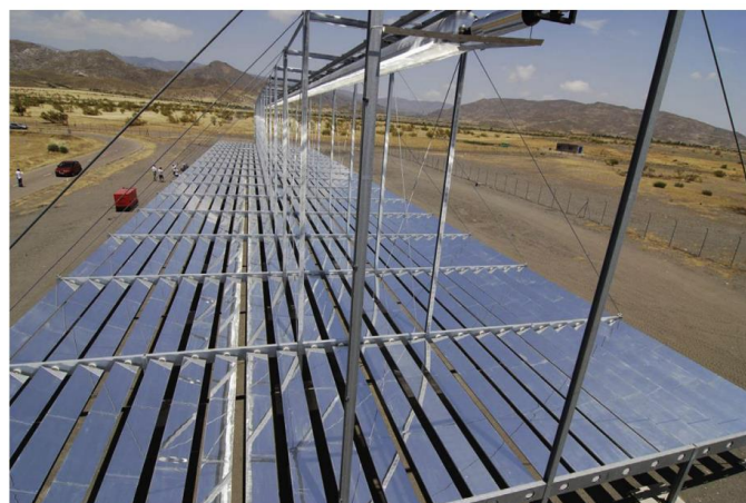
Figura 23. Circuito de prueba de colector lineal de Fresnel de 100 metros en la Plataforma Solar de Almería, España.
