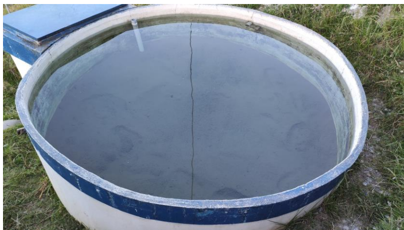
Figura 88 Filtro lento de arena PTAP Patapamba
