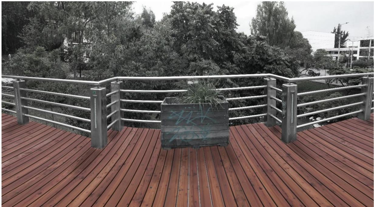
*Figura 84 Vista sobre el río Tomebamba del puente Cesar Dávila Andrade – Madera Plástica*
