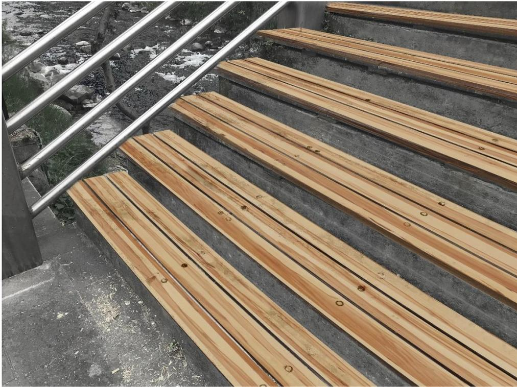
*Figura 87 Vista de las gradas del puente Cesar Dávila Andrade – Madera Natural*
