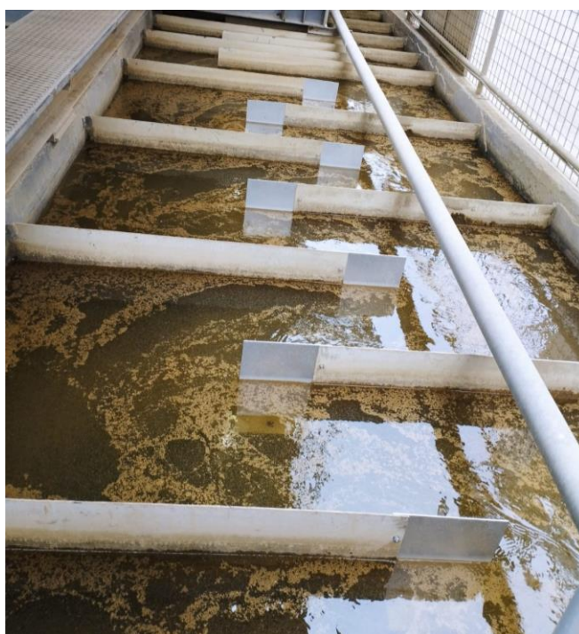
Figura 7. Floculador hidráulico de pantallas de flujo horizontal.
