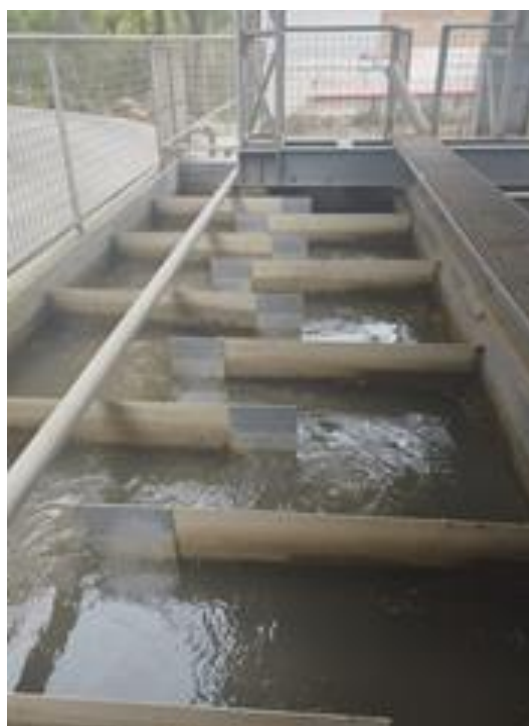
Figura 25. Adición en las pantallas en el tramo 3 del reactor.
