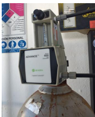
Figura 3. Dosificador de cloro a presión.
