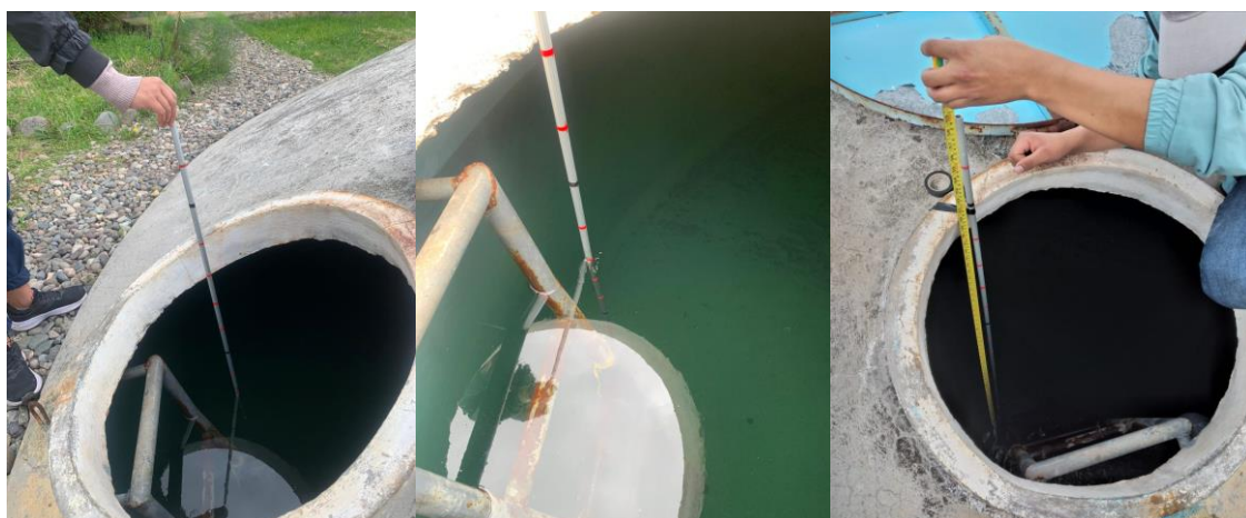
Figura 29. Medición del caudal utilizando el método volumétrico.
