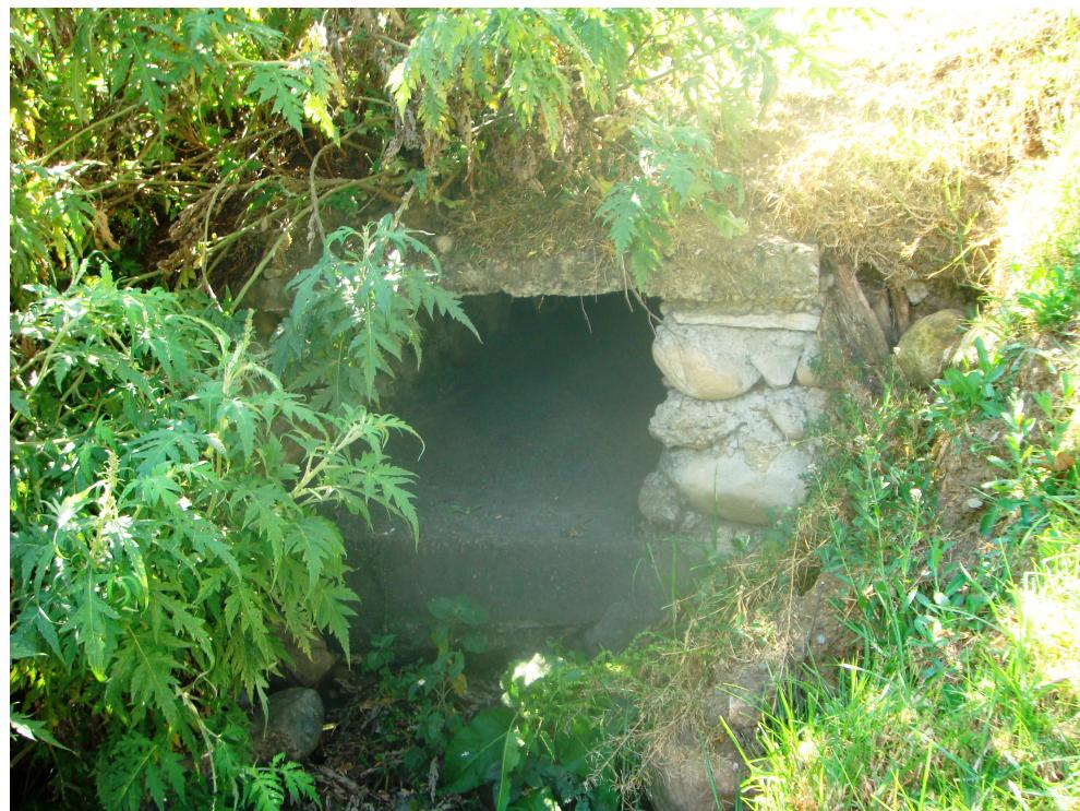
**Figura 7.11: Alcantarilla de descarga de los colectores de la Calle Larga y Hermano Miguel (Tramo 1).**
