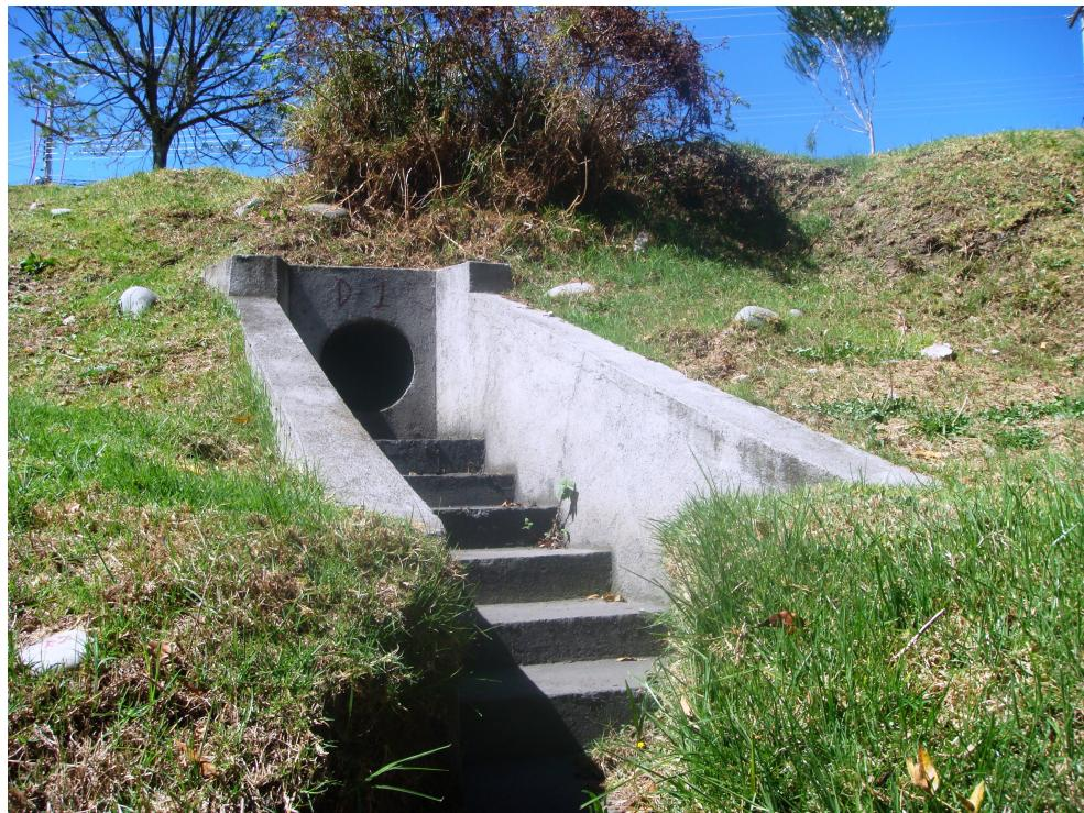
**Figura 7.8: Escaleras de disipación de energía en la salida de la alcantarilla (Tramo 2).**
