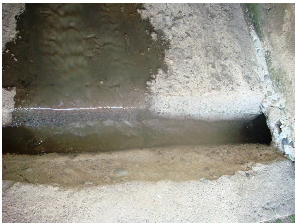
**Figura 7.15:** Canal construido a la salida del colector de la calle Miguel Vélez.
