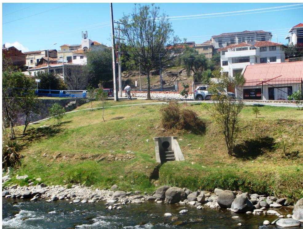
**Figura 7.7: Alcantarilla de descarga del caudal de alivio de la Calle Larga (Tramo 2).**
