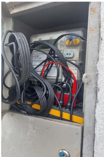
**Figura 3.6:** Instalación del Fluke 1746 en el Medidor del cliente Residencial.
