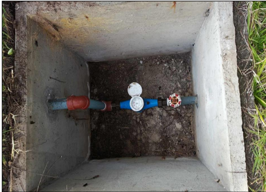
Figura 3.5. Elementos de la entrada de agua para el reservorio. Fuente: Los autores.
