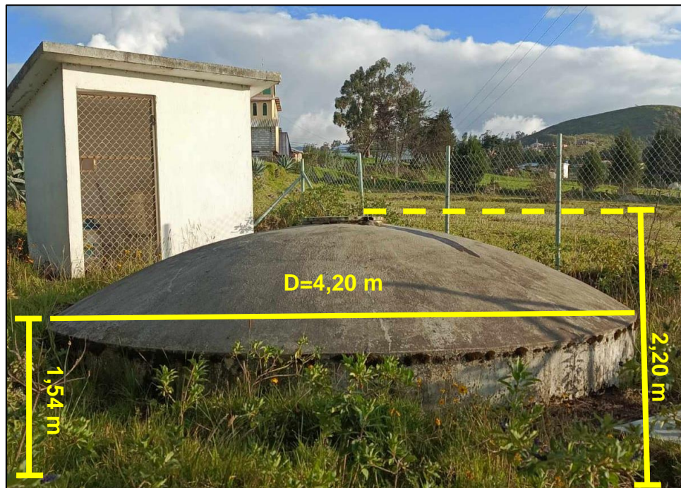
Figura 3.3. Reservorio de agua de la comunidad Chaglabán. Fuente: Los autores.
