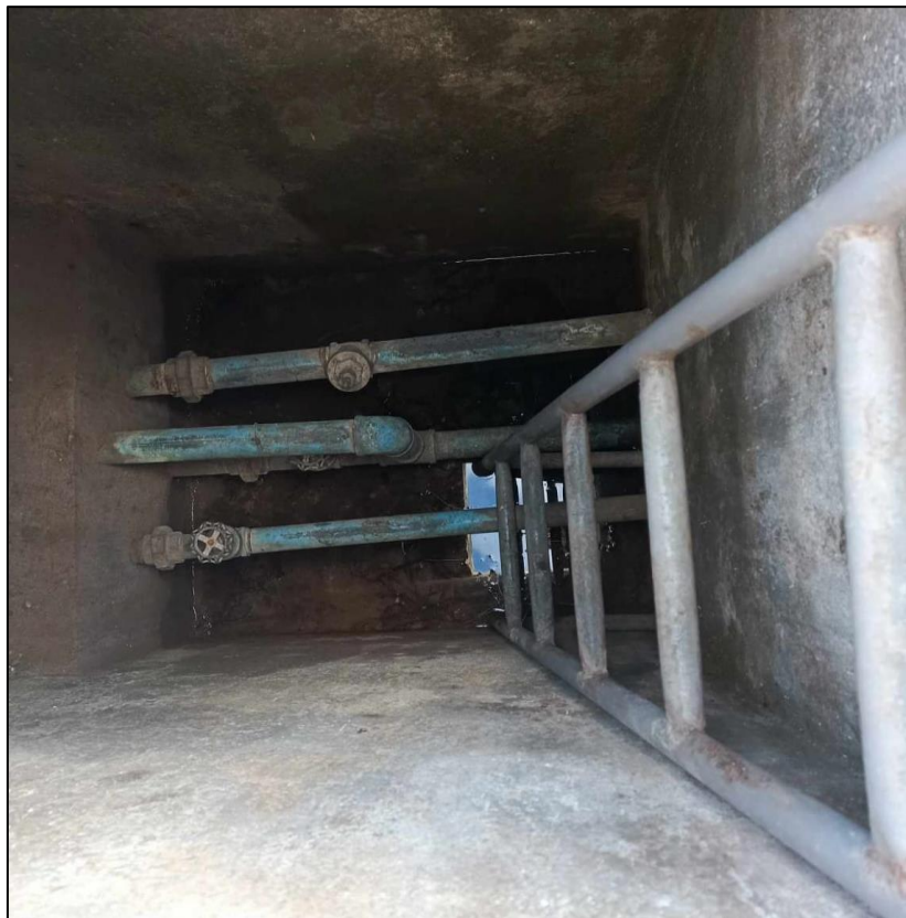
Figura 3.8. Tubería de salida del reservorio de gua, hacia los consumidores. Fuente Los: autores.
