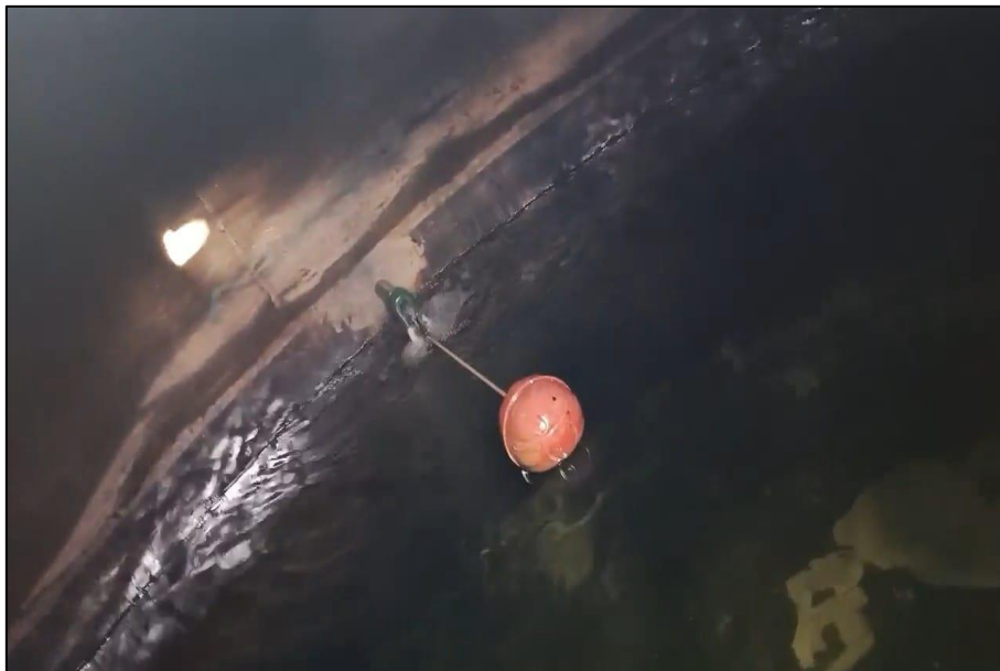
Figura 3.9. Boya de nivel dentro del tanque, para el accionamiento de una válvula de entrada. Fuente Los autores.
