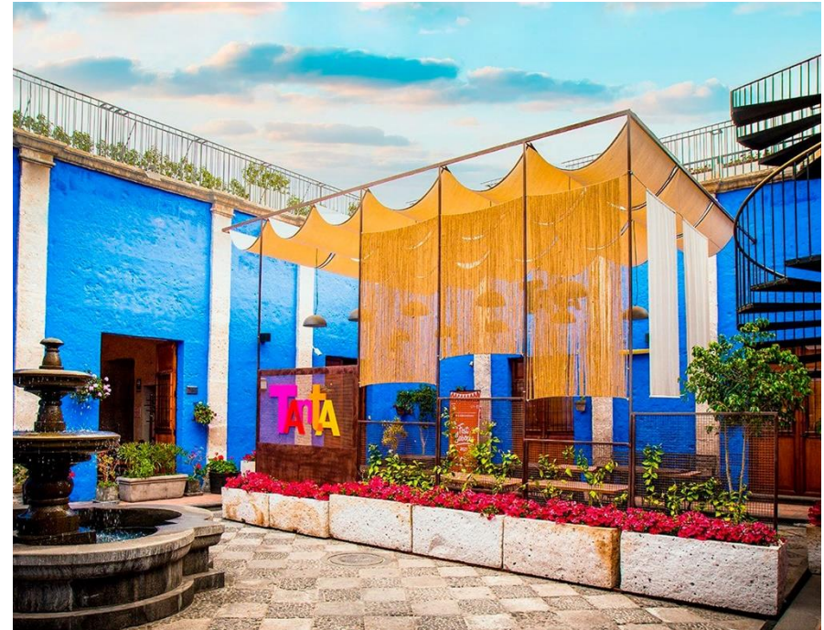
Figura 35. Intervenciones de arquitectura nueva calle Melgar, Casona Santa Catalina.
