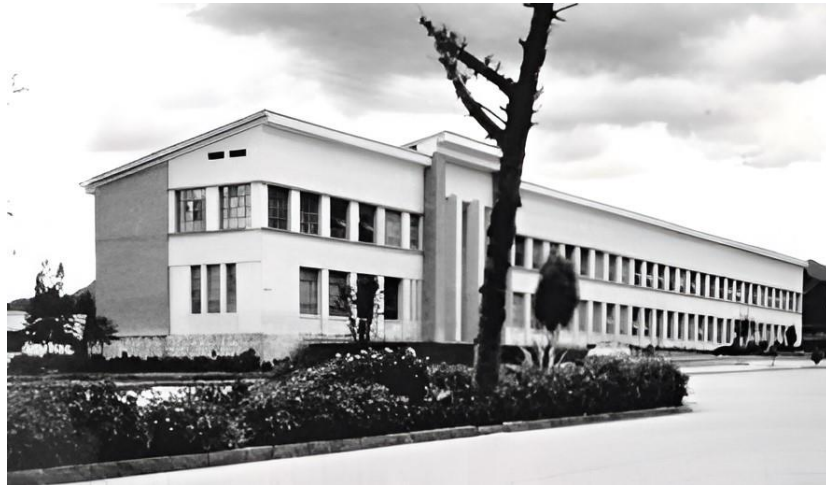
Figura 14 Facultad de Filosofía, primera construcción
