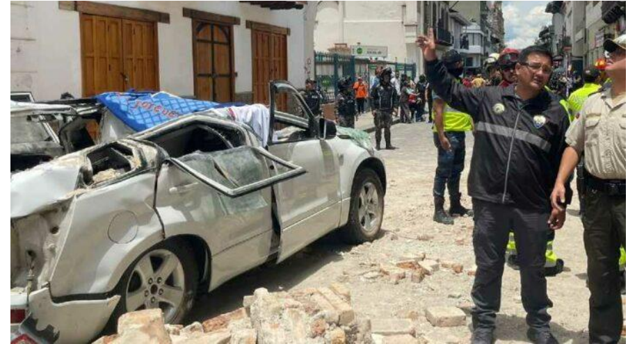
Figura 8 La fachada de una vivienda colapsó en Cuenca y dejó una persona fallecida
