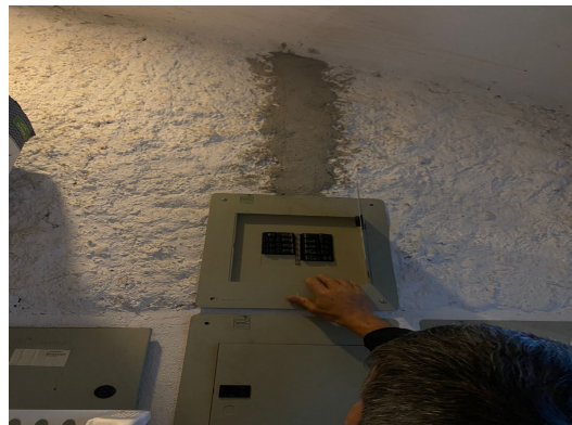
Figura 22 Caja de interruptores para luces exteriores
