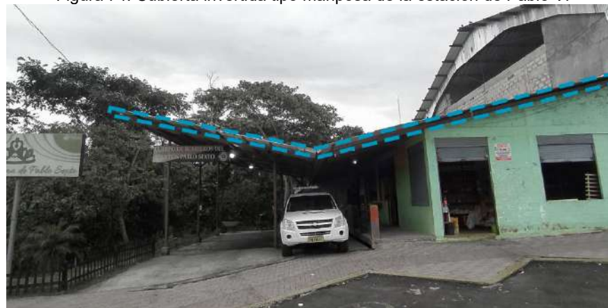
Figura 74. Cubierta invertida tipo mariposa de la estación de Pablo VI
