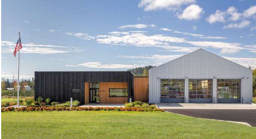
Figura 20. Estación de bomberos 76
