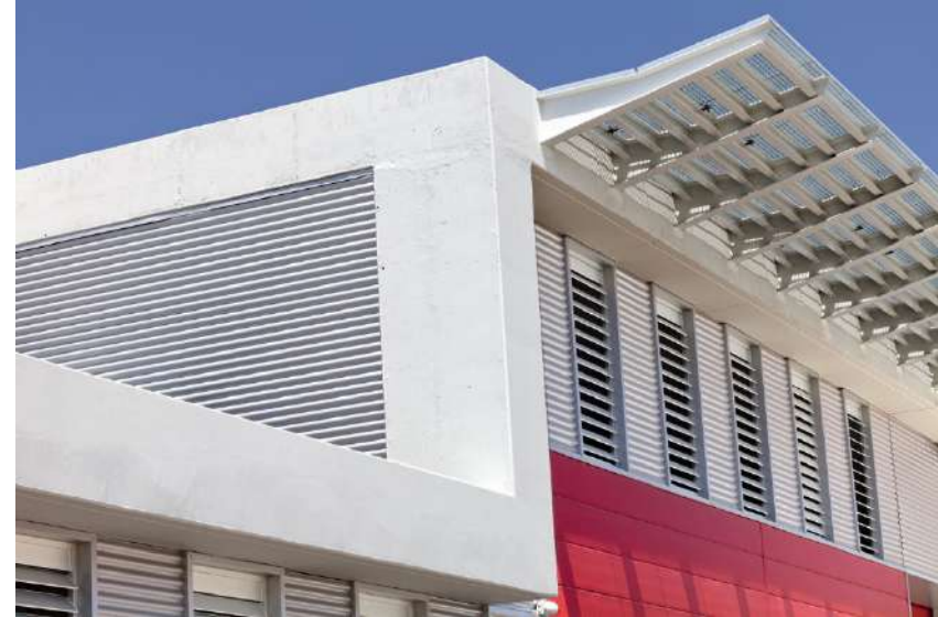
Figura 48. Recubrimiento de chapa metálica ondulada y ventanas de aluminio
