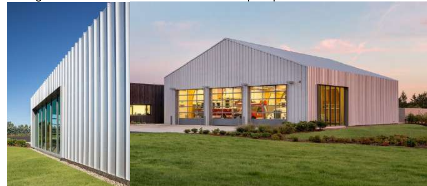
Figura 36. Revestimiento metálico del bloque operativo de la Estacion 76
