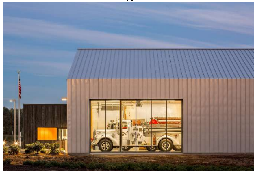
Figura 24. Fachada lateral Estación de bomberos 76
