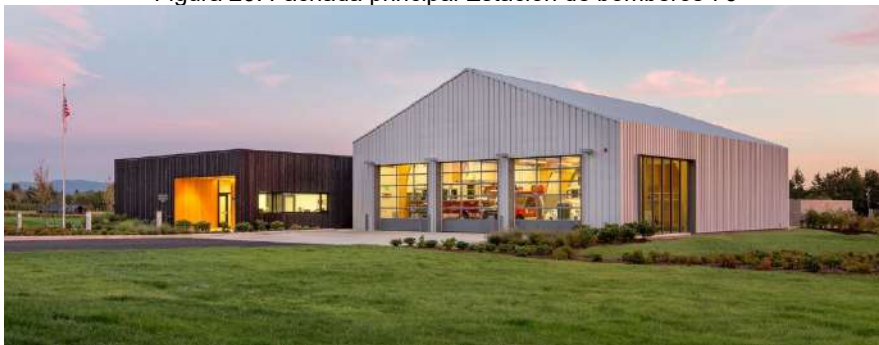
Figura 26. Fachada principal Estación de bomberos 76
