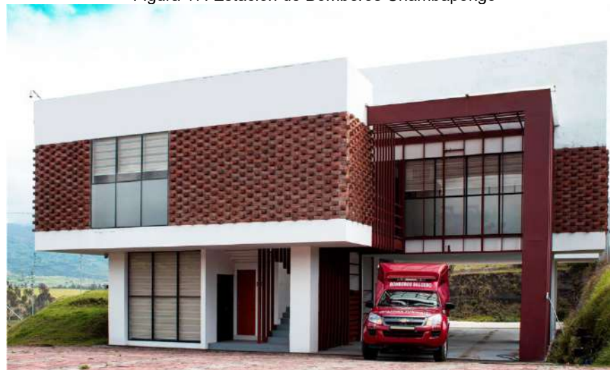
Figura 17. Estación de Bomberos Chambaongo
