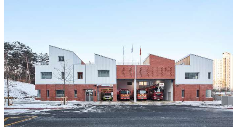
Figura 21. Estación de bomberos Gangil 119
