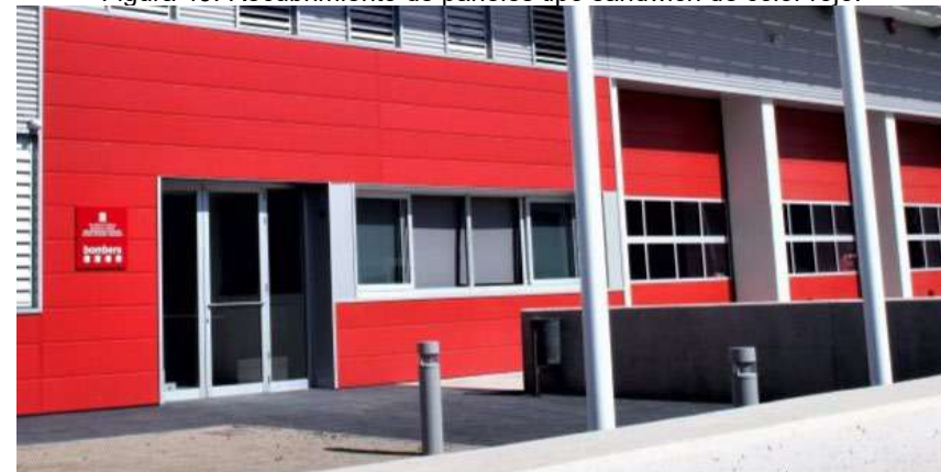
Figura 49. Recubrimiento de paneles tipo sandwich de color rojo.
