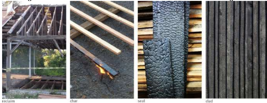
Figura 34. Procedimiento de la técnica de carbonizado Shou Sugi Ban
