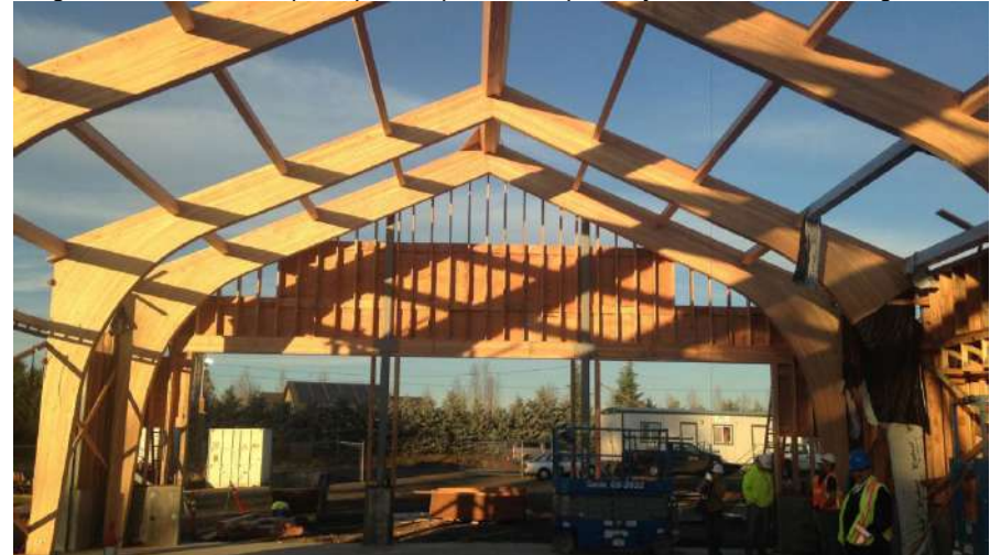
Figura 35. Estructura principal bloque de máquinas y vehículos de emergencias
