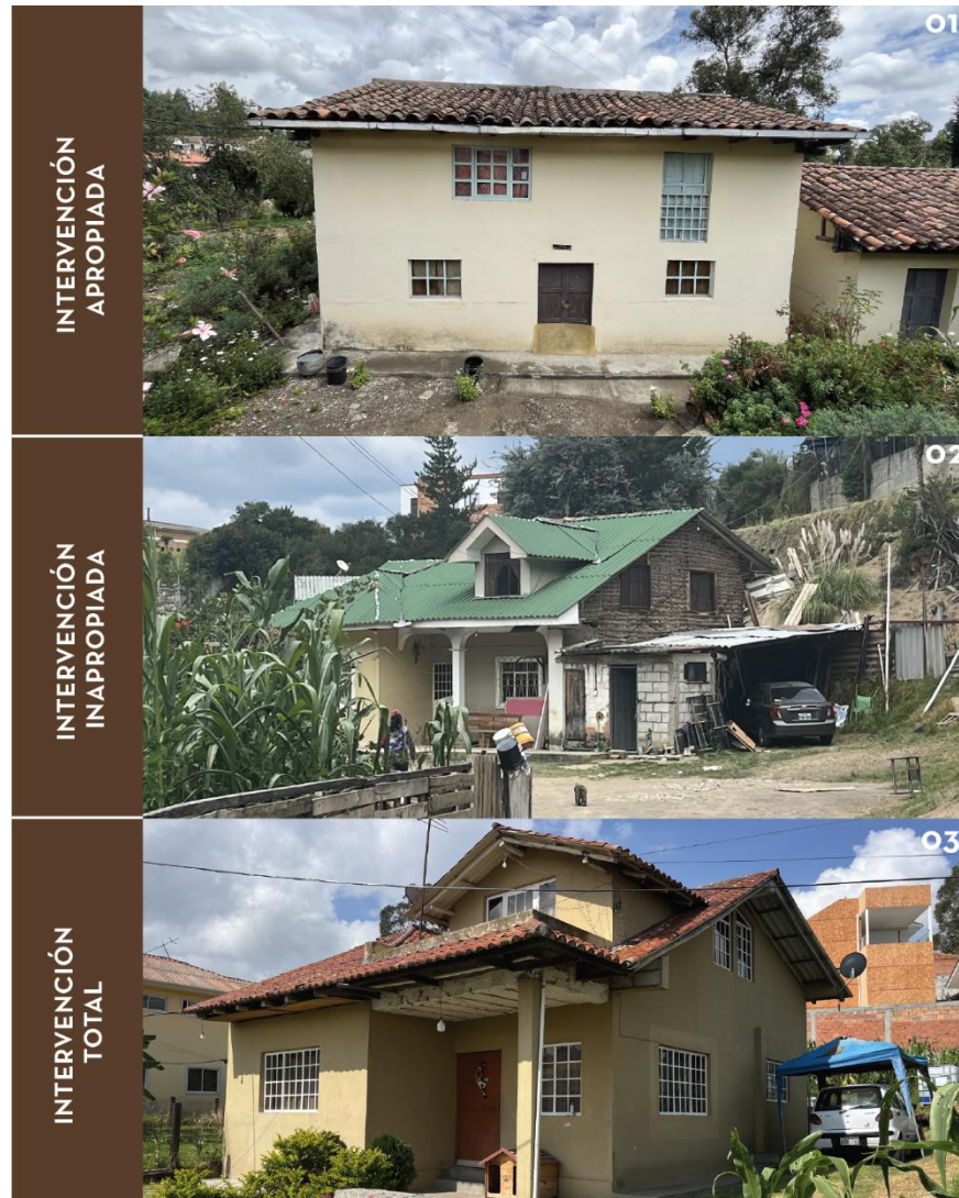
Figura 27. Ejemplos de edificaciones intervenidas
