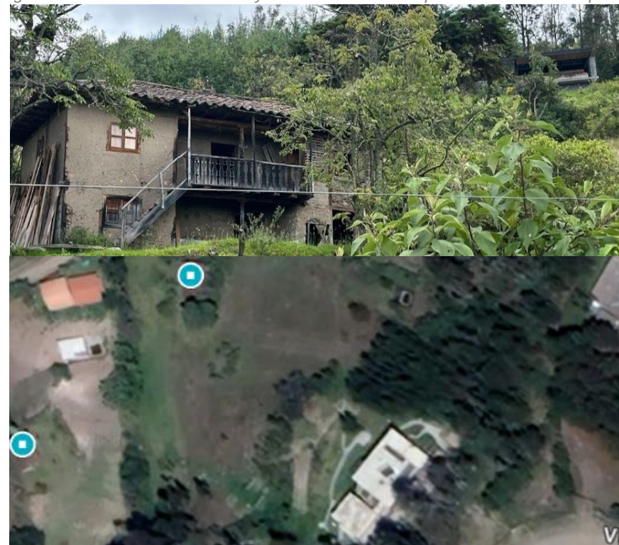
Figura 33. Inmueble abandonado y construcción contemporánea en el mismo predio
