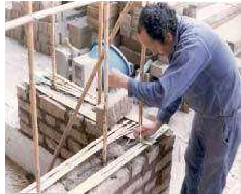
Figura 64: Procedimiento sistema de refuerzo de cañas.
