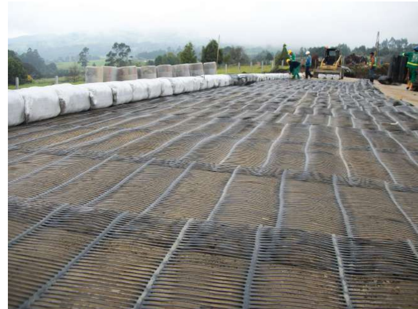
Figura 49: Uso de geomallas uniaxiales.
