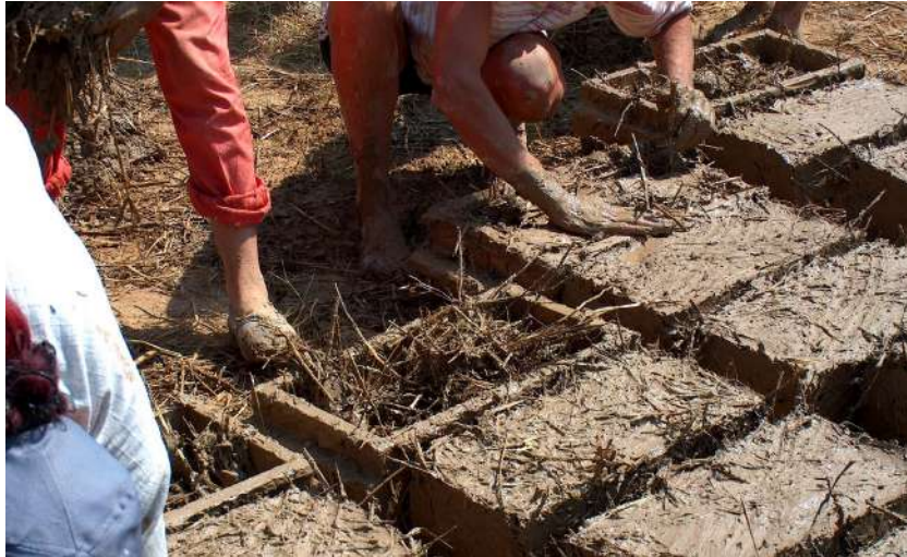
Figura 17: Proceso de moldeo de los adobes.
