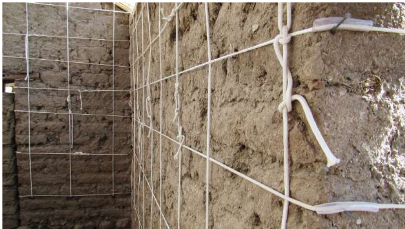
Figura 46: Sistema de drizas, nudo.
