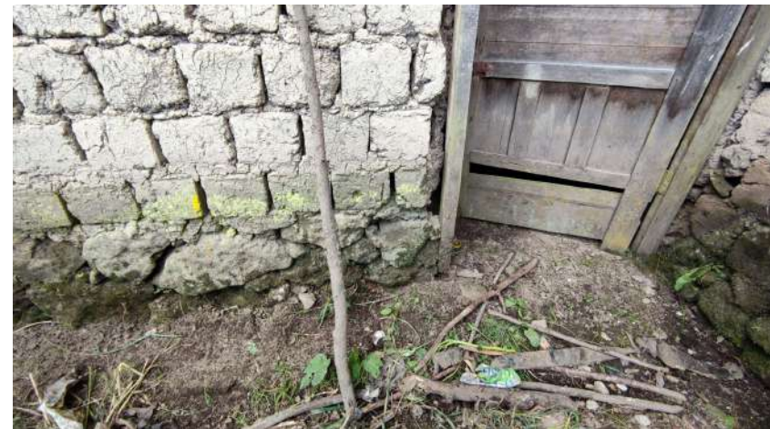
Figura 40: Crecimiento biológico en muro de adobe.
