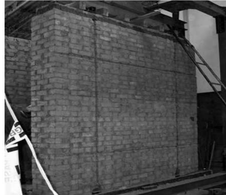
Figura 65: Sistema con tensores de acero.
