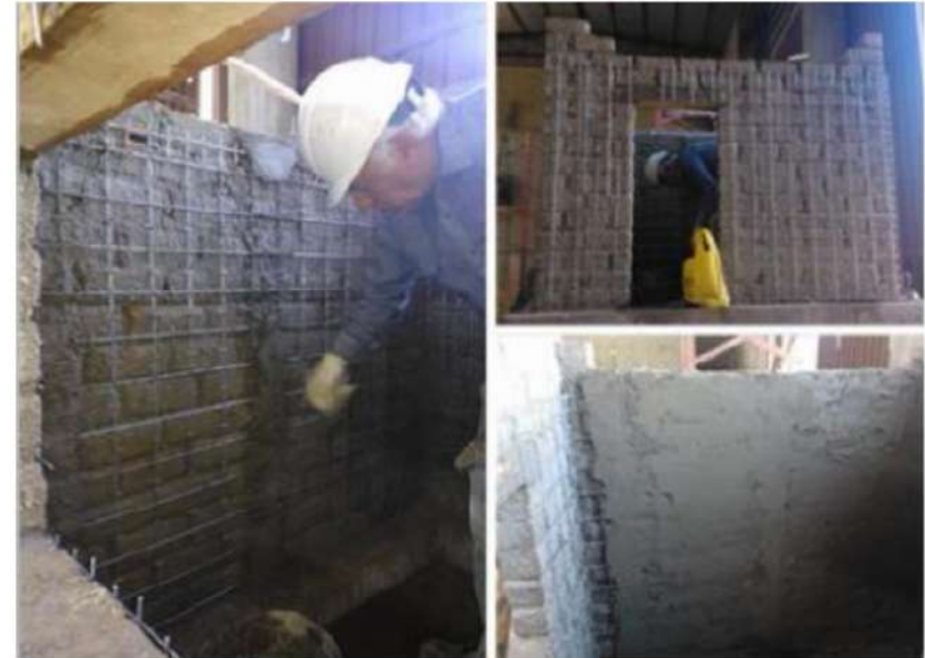
Figura 61: Colocación y recubrimiento malla metálicas en muro.
