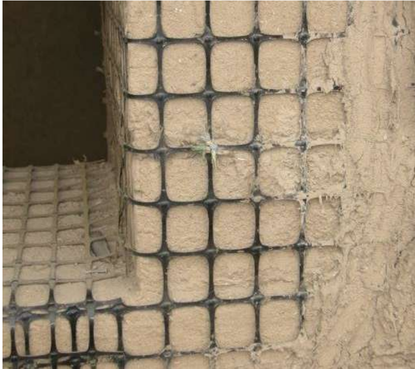
Figura 51: Geomalla biaxial en muro.
