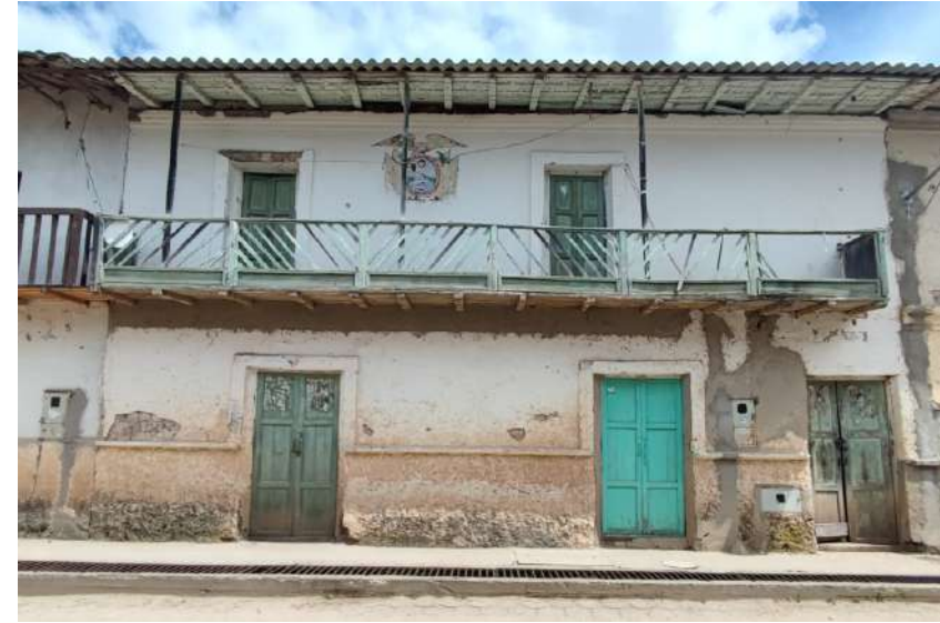
Figura 35: Vivienda de adobe con cubierta de eternit e incorporación de cemento
