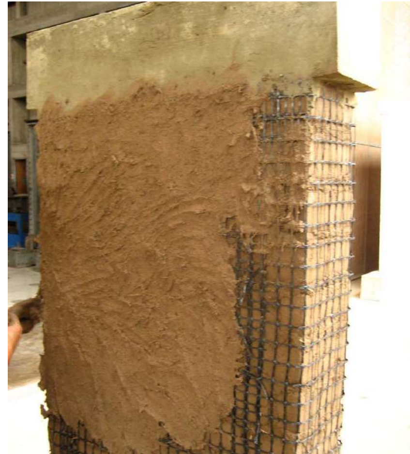
Figura 62: Mallas electrosoldadas esquineras.
