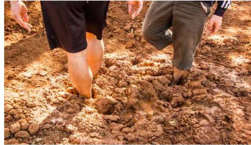
Figura 16: Proceso de batido del barro.
