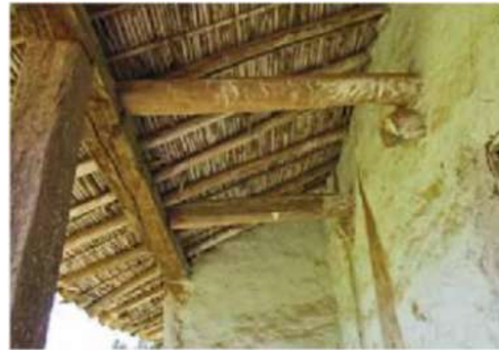
Figura 25: Enchanclado o cama de carrizo.
