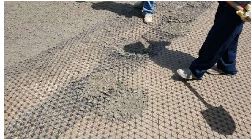
Figura 53: Aplicación geomalla triaxial.
