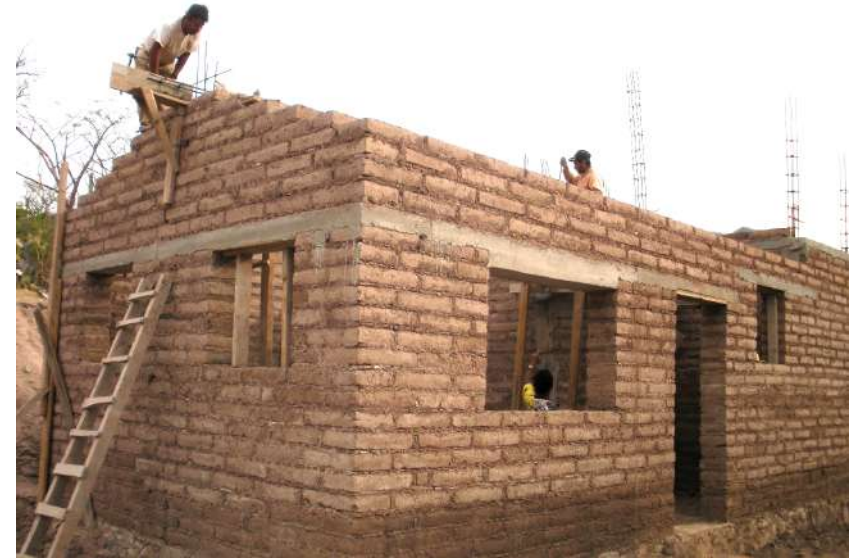
Figura 36: Vivienda de adobe con vigas de hormigón.
