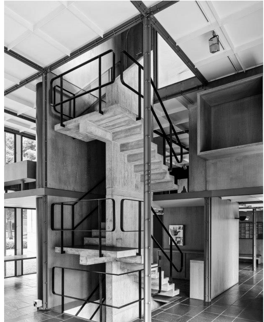
Figura 49. Pabellón Suizo | Escalera
