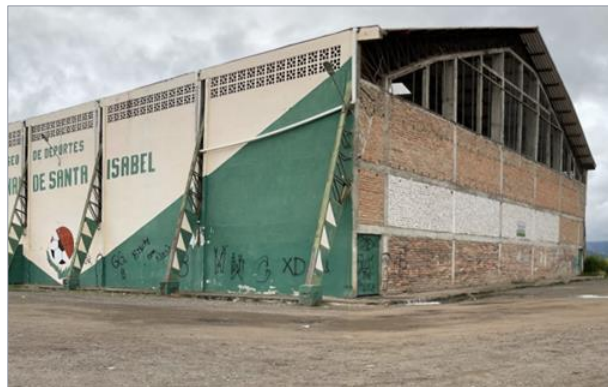
Figura 2.12 Coliseo de Deportes Fuente: Elaboración propia
