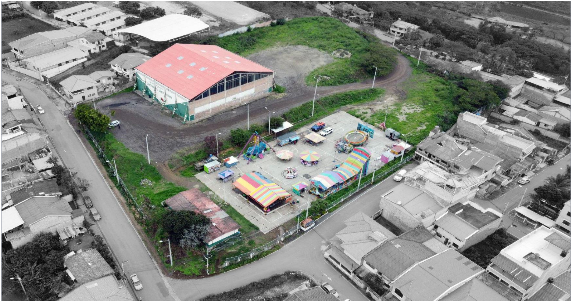
Figura 4.6 Estado actual Fuente: Elaboración propia
