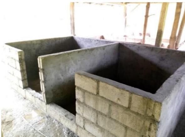
Foto 1.3. Compostera construída
