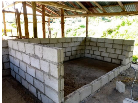
Foto 1.2. Construcción de compostera con bloque
