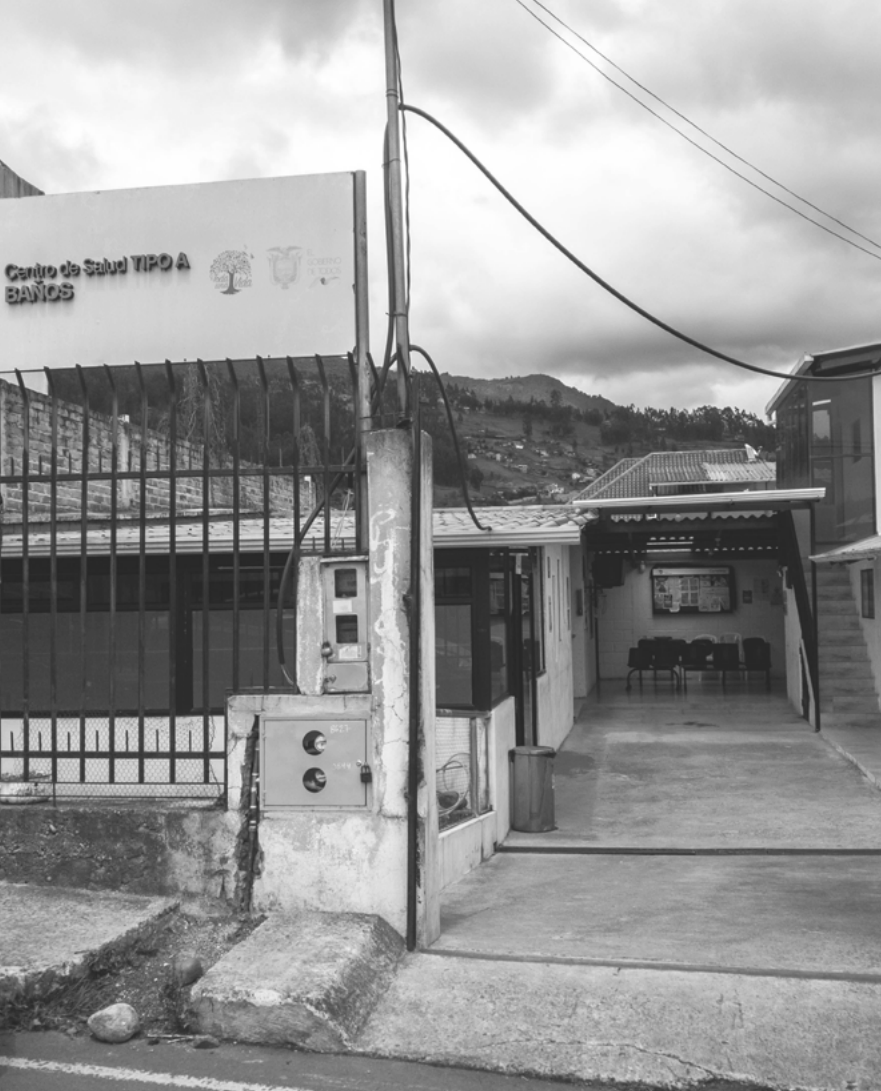
Figura 084. EQ2 - Centro de salud de Baños
