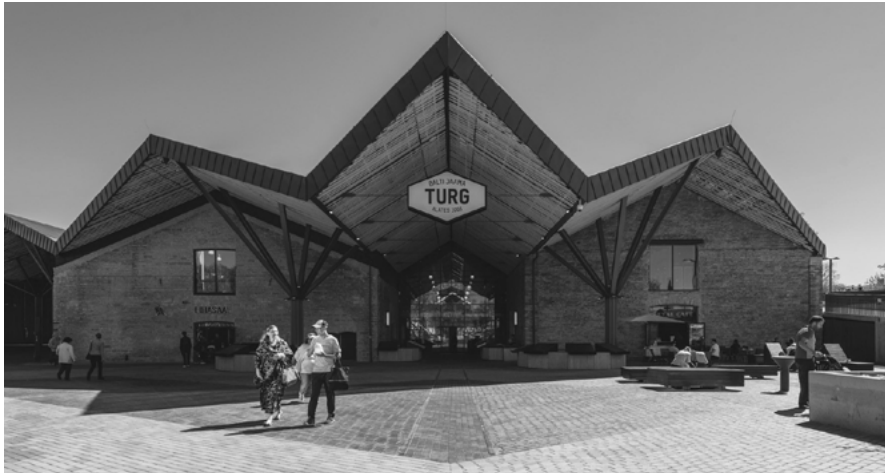
Figura 032. Mercado Estación Báltica
