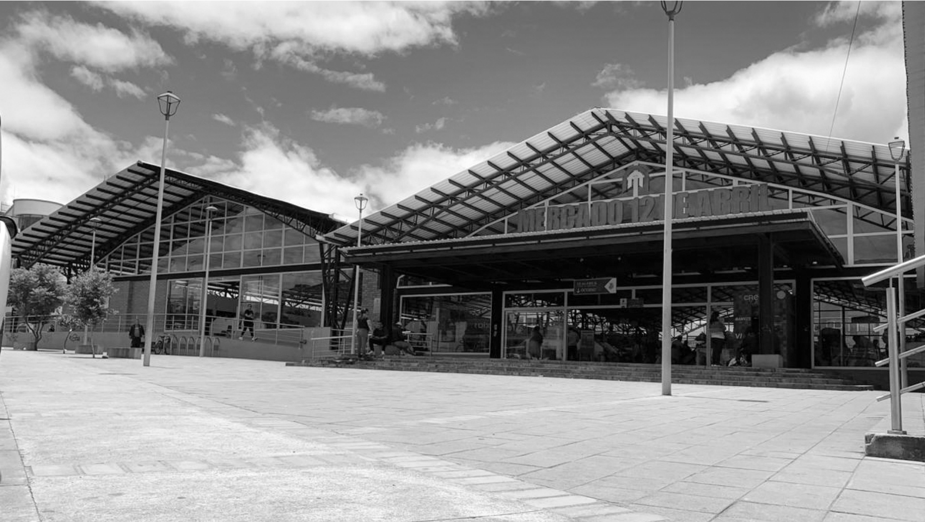
Figura 034. Fachada principal del Mercado 12 de Abril
