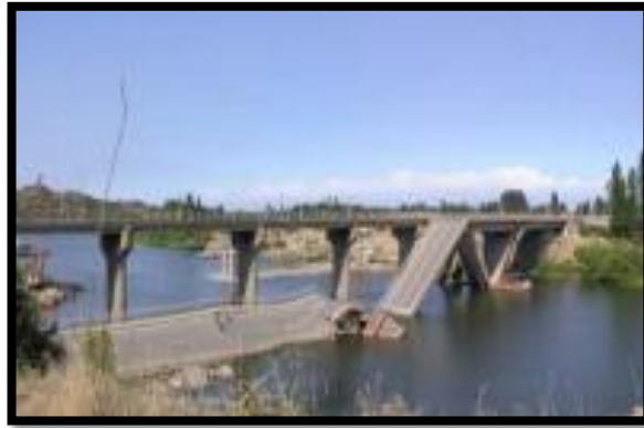
Fig. 26. Ejemplo típico del efecto de la socavación en puentes. (Fuente: Manual de Transportes y Comunicaciones, Perú)
