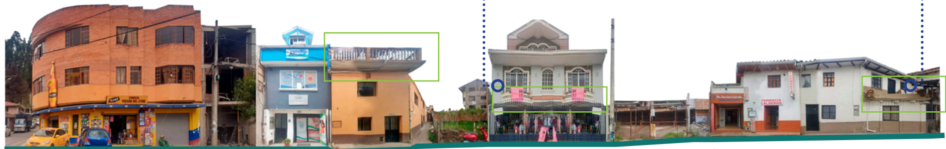
Figura 134 Tramo Calle Sin Nombre Elementos representativos:
